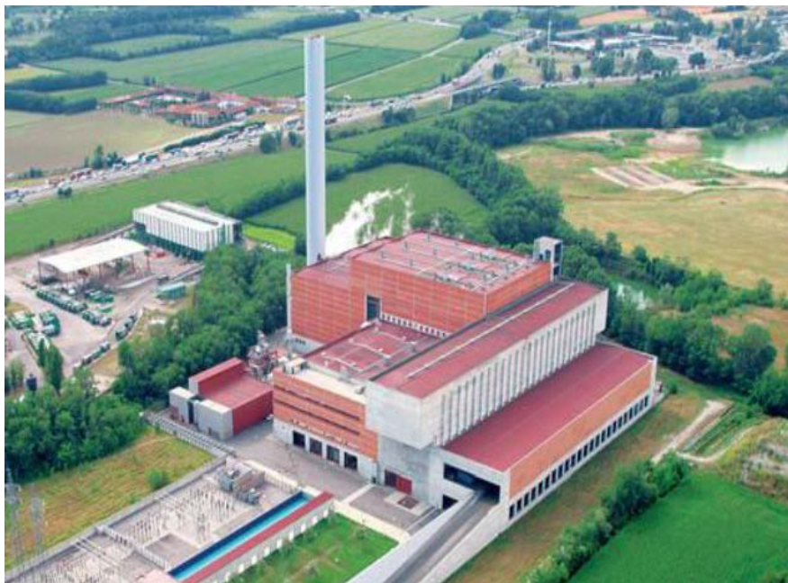
Figura 2.1. Veduta aerea del termovalorizzatore Silla 2 di Milano. (Fonte Vergani)
