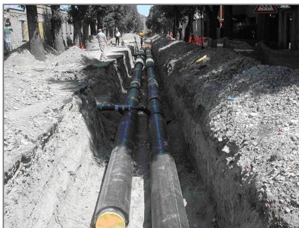
Figura 2.13. Posa di tubazioni del teleriscaldamento. (Fonte ASM)
