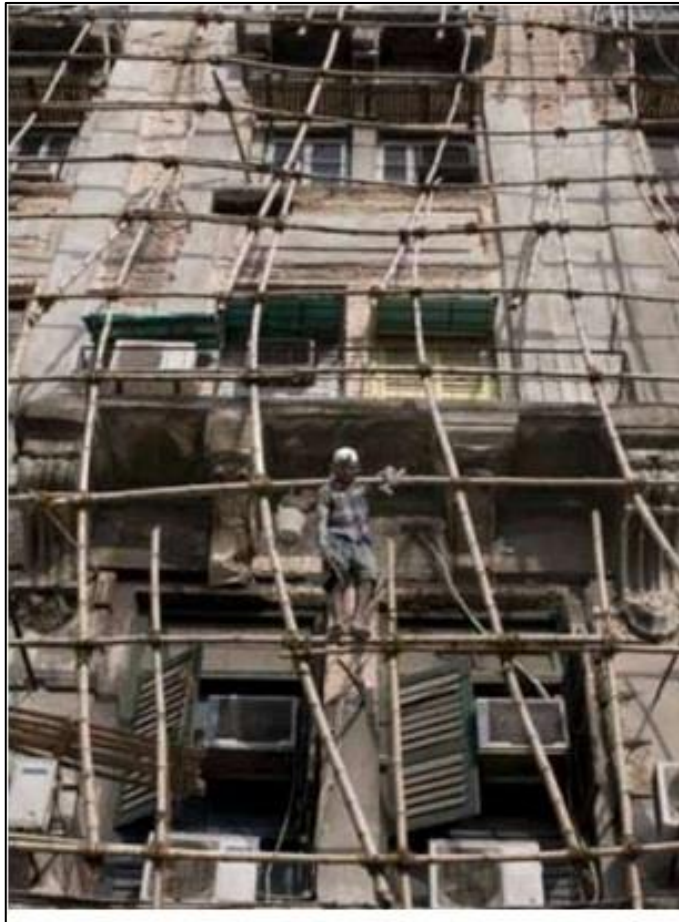
FIGURA 121 BUCKLING IN TUTTI I PILASTRINI SNELLI IN UN PONTEGGIO
