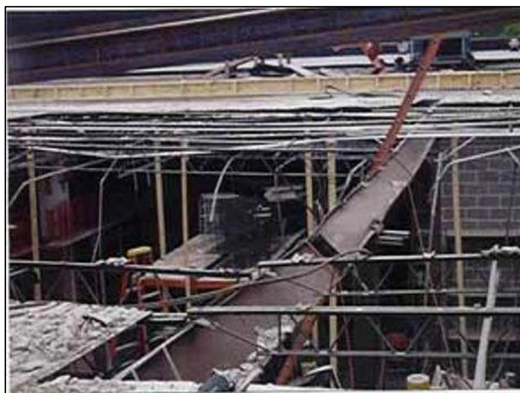
FIGURA 117 BUCKLING FLESSO-TORSIONALE DI TRAVE IN ACCIAIO
