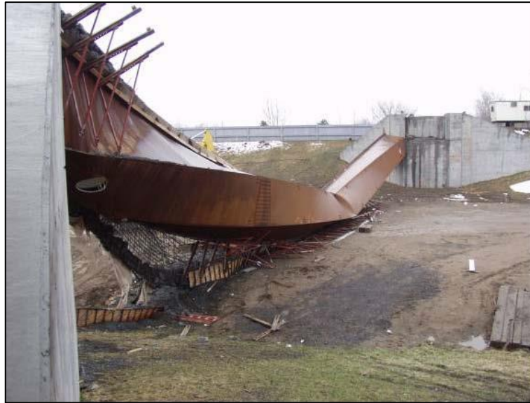
FIGURA 92 IL MARCY BRIDGE COLLASSATO
