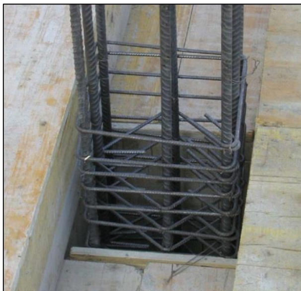
FIGURA 86 PILASTRO CON STAFFE CORRETTAMENTE FITTE
