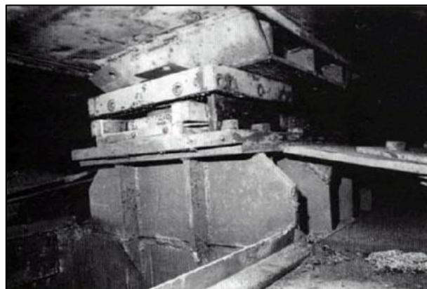
FIGURA 71 APPOGGIO "L" NORD DELL'ANELLO DI BORDO
