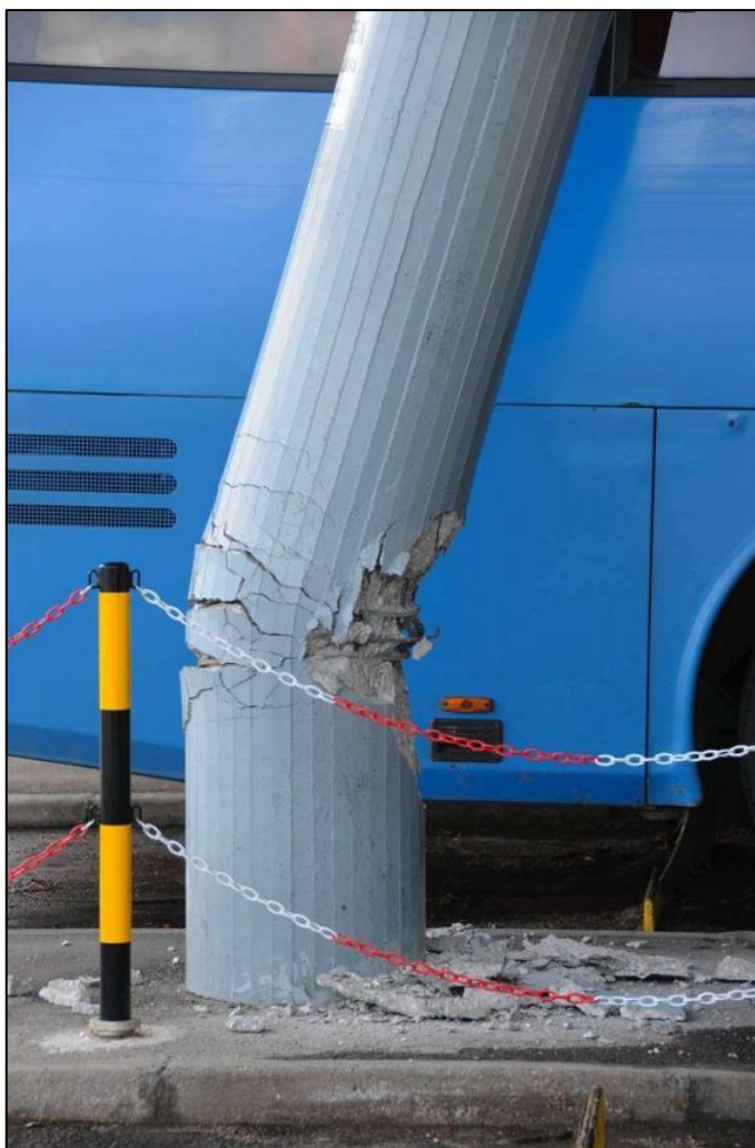
FIGURA 97 COLONNA DI UNA PENSILINA DEGLI AUTOBUS A CLES CON I TONDINI DEFORMATISI PER CARICO DI PUNTA
