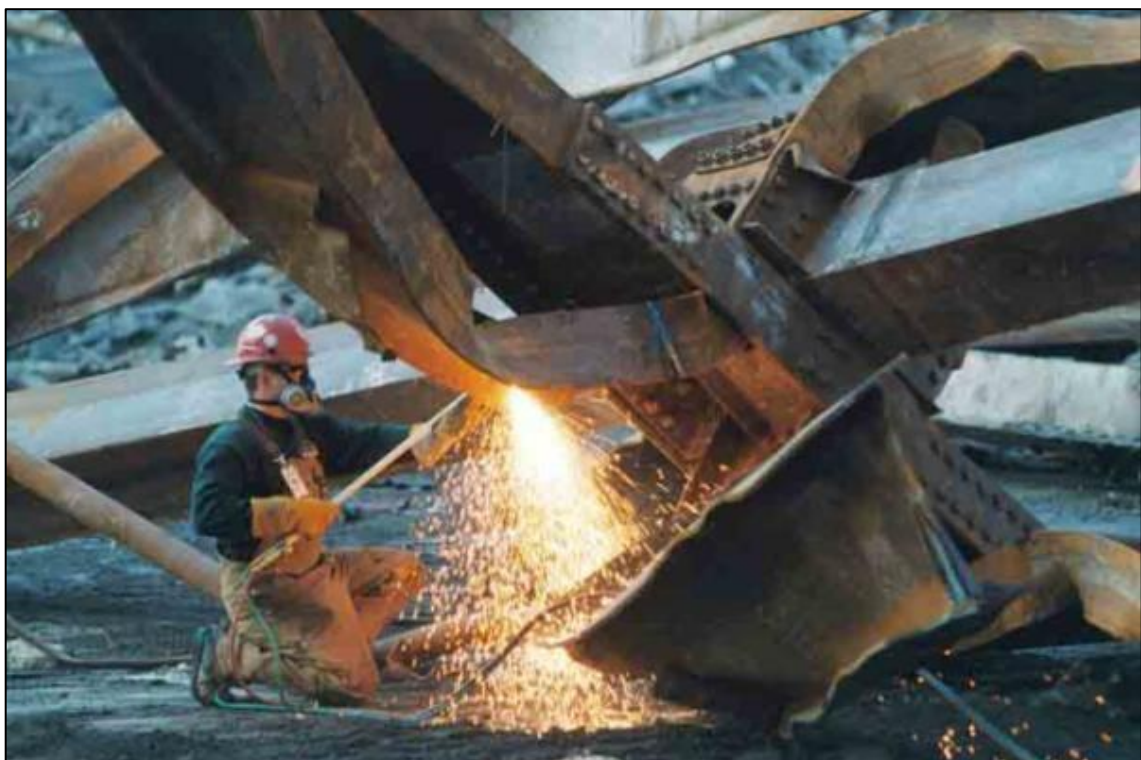
FIGURA 62 OPERAIO INTENTO A SEZIONARE I PILASTRI DI UNA DELLE TORRI GEMELLE PER POTERLI SMANTELLARE
