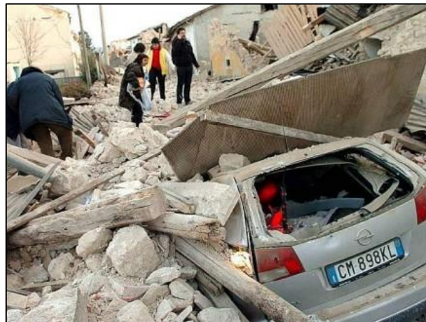
FIGURA 82 CROLLO DI UN EDIFICIO PER IL TERREMOTO IN ABRUZZO
