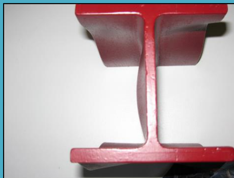
FIGURA 55 IMBOZZAMENTO DI UNA TRAVE A "I"
