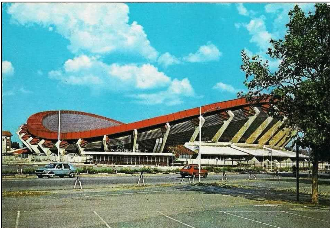
FIGURA 64 IMMAGINE D'EPOCA DEL PALAZZETTO DELLO SPORT DI MILANO PRIMA DEL CROLLO DEL 1985
