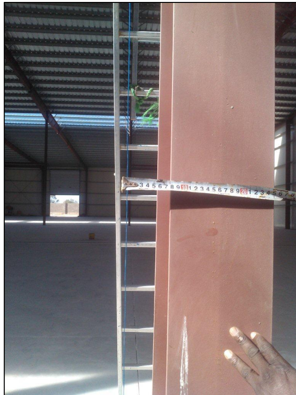
FIGURA 123 IL BUCKLING DI CUI SOPRA MISURATO COME SCOSTAMENTO DAL FILO A PIOMBO
