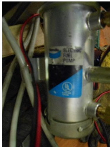
Figura 2.7: Pompa di benzina a bassa pressione per ricaricare il serbatoio
