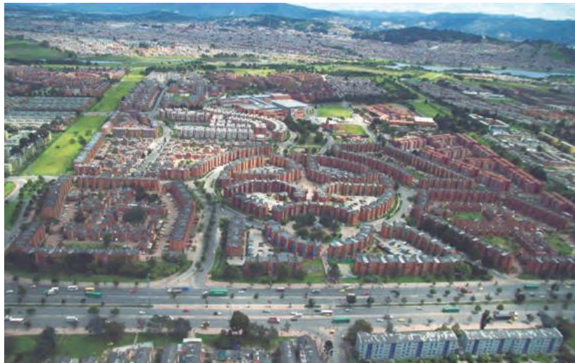
Figura 2.3 : Vista del quartiere Ciudadela Colsubsidio
