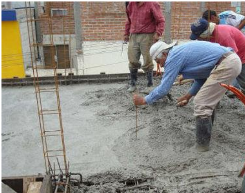
Figura 5.36 : Vibrazione del calcestruzzo
