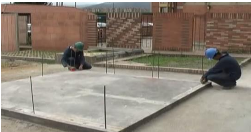
Figura 5.8 : Fondazione completa
