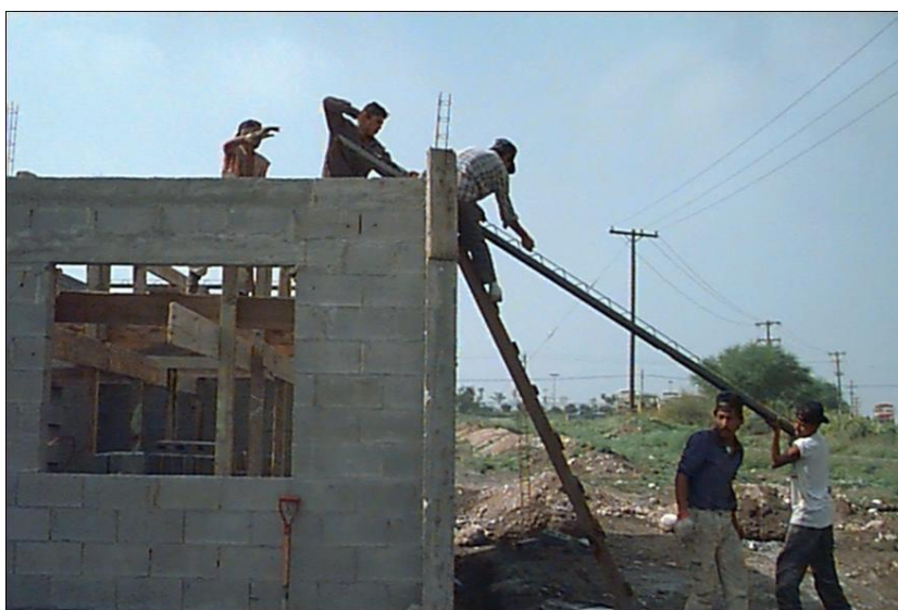
Figura 5.33 : Fissaggio dei travetti
