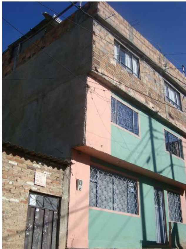
Figura 4.13 : Abitazione con uno sbalzo per ogni piano e sbalzo nel parapetto
