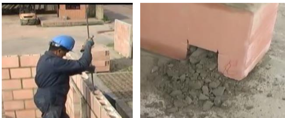
Figura 5.25 : Pulizia per inserimento del rinforzo
