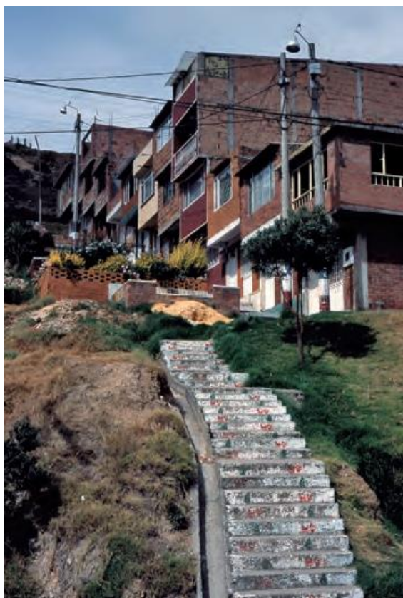
Figura 2.4 : Abitazioni di Ciudad Bolivar costruite in zone con forte pendenza
