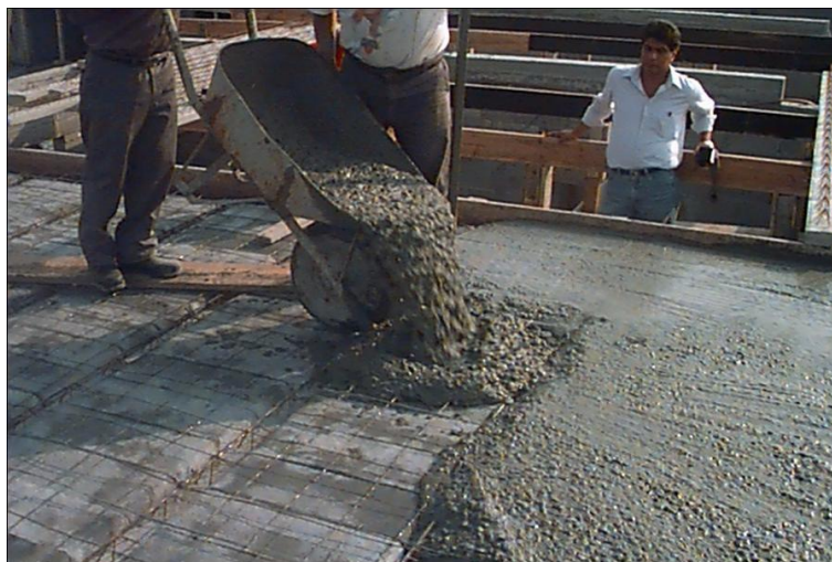
Figura 5.35 : Getto del calcestruzzo
