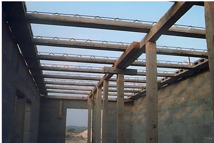
Figura 5.31 : Posizionamento dei rompi tratta
