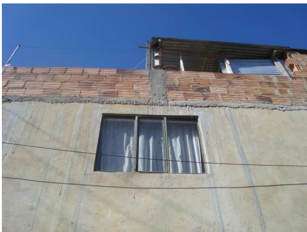
Figura 4.26 : Impiego di diversi materiali da costruzione
