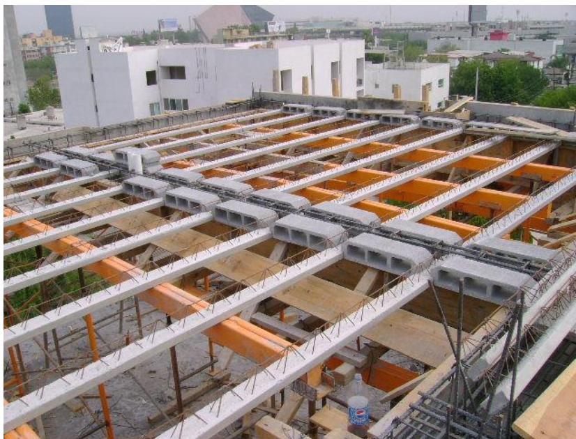
Figura 5.32 : Prime fasi di posizionamento dei mattoni
