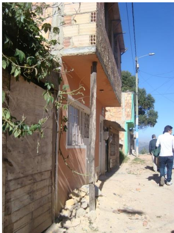
Figura 4.19 : Immagine di un supporto instabile
