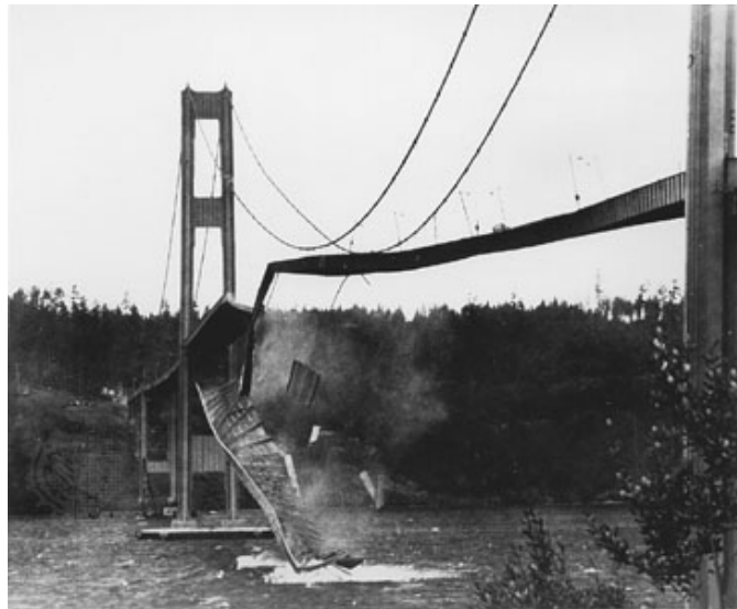
Figura 1: Crollo del ponte Tacoma, 10 Novembre 1940
