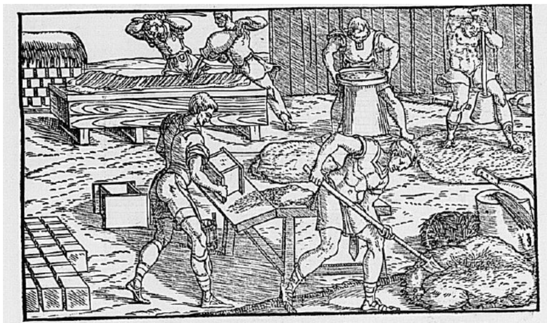
Fig. 9 – processo costruttivo di mattoni in terra cruda: si noti l’attenzione al processo di “raffinazione” della terra
