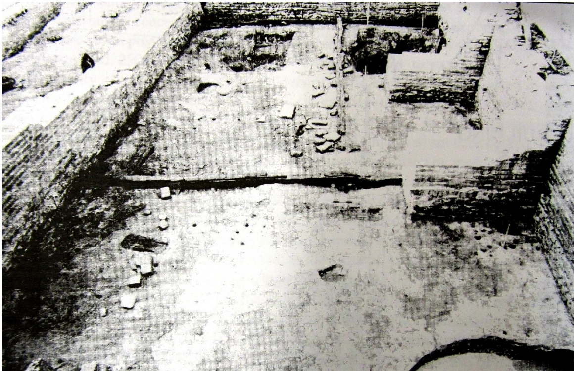
Fig. 46 – Veduta dell'edificio 13 (GADD, WARD PERKINS 1991, p 110). Si noti la trave orizzontale con scanalature nella parte superiore della fotografia.
