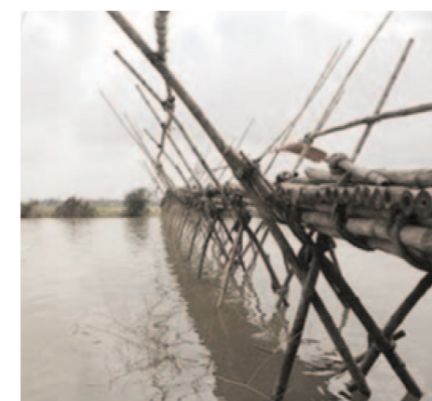
Ponte in Vietnam [foto di Ed Fladung]
