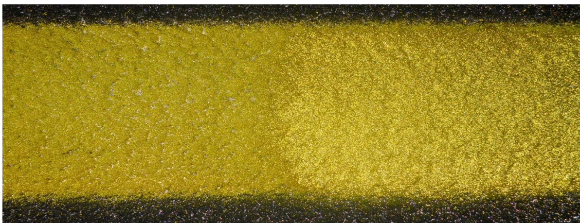
Figura 5.10: Punto di stacco tra microsfere Type I e microsfere Type III sulla centerline di taxiway della zona Cargo Sud.
