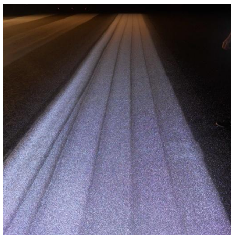
Figura 4.39: Sovrapposizione delle stese adiacenti al bordo del segnale orizzontale.
