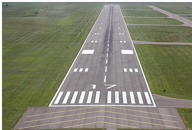
Figura 1.3: Markings di soglia, asse pista, bordo pista e TDZ.
