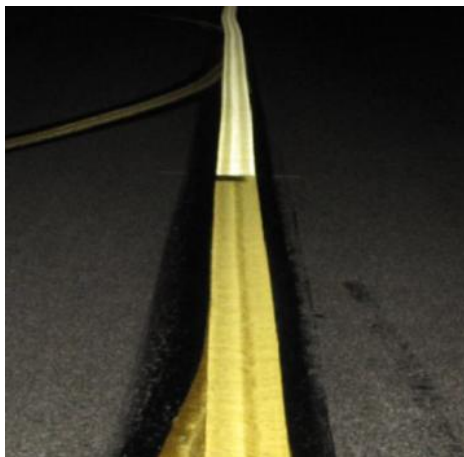
Figura 3.2: Center line di taxiway realizzata con microsfere Type I e Type III.
