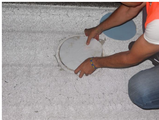
Figura 4.41: Copertura dei fuochi di pista prima del passaggio del macchinario di stesa.
