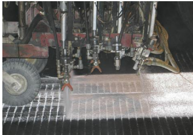
Figura 2.13: Applicazione a pressione di microsfere di vetro postspruzzate.
