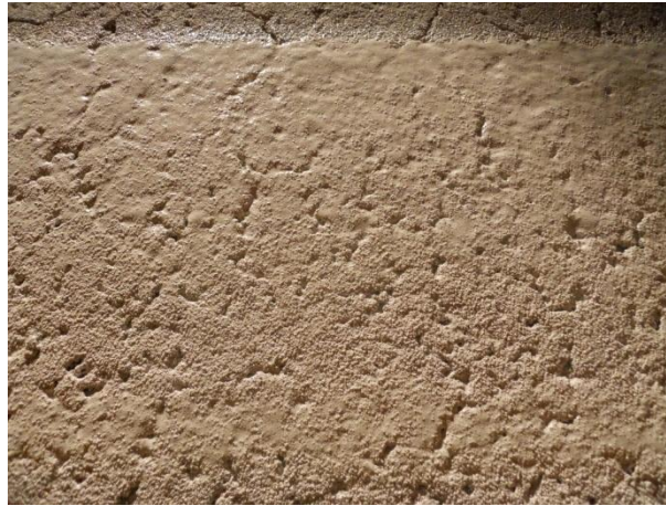
Figura 4.37: Spessore non uniforme della stesa di pittura.
