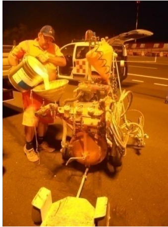
Figura 4.40: Introduzione della pittura impiegata all'interno del serbatoio del macchinario di stesa.
