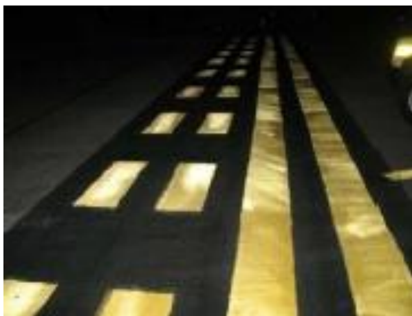
Figura 2.15: Disuniformità della distribuzione di microsfere causata da un'applicazione di tipo manuale.
