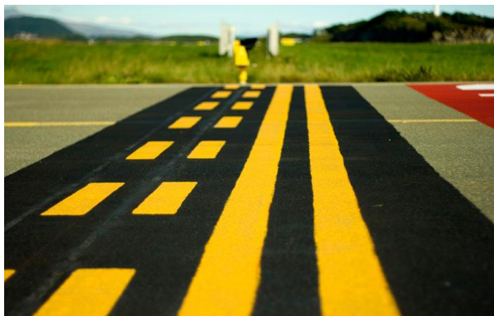
Figura 1.4: Segnaletica orizzontale relativa ad una posizione di attesa.
