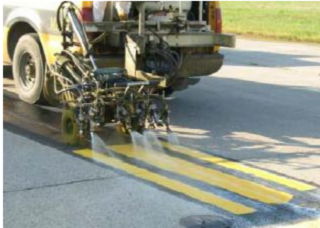
Figura 2.7: Sistema pneumatico per l'applicazione di pitture da segnaletica orizzontale.
