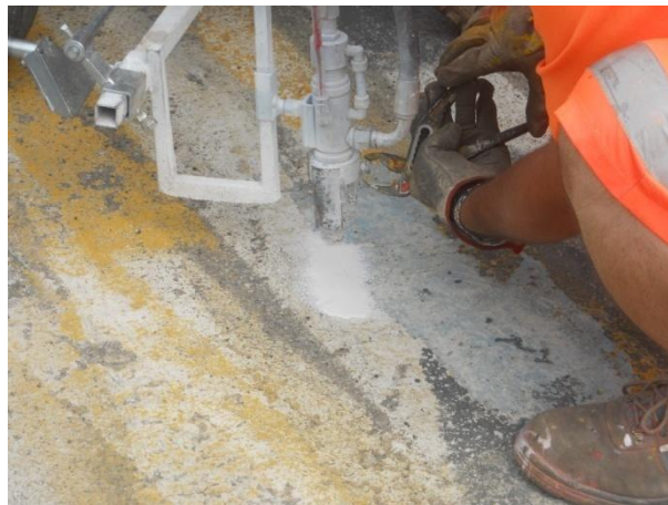
Figura 4.11: Definizione del corretto posizionamento delle pistole di stesa.
