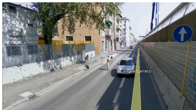
Figura 3.4.1: foto di via dé Carracci adiacente al cantiere ferroviario
