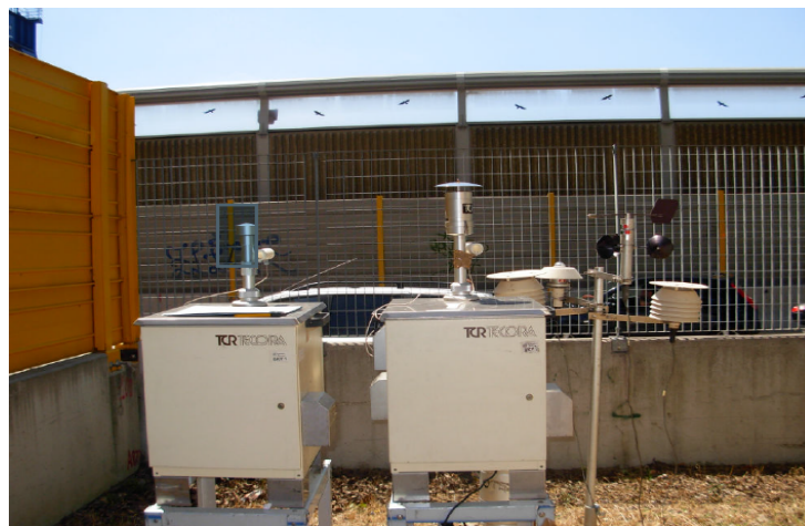
Figura 3.4.3: stazione n°1 di monitoraggio di Igeam nel cantiere di Bologna
