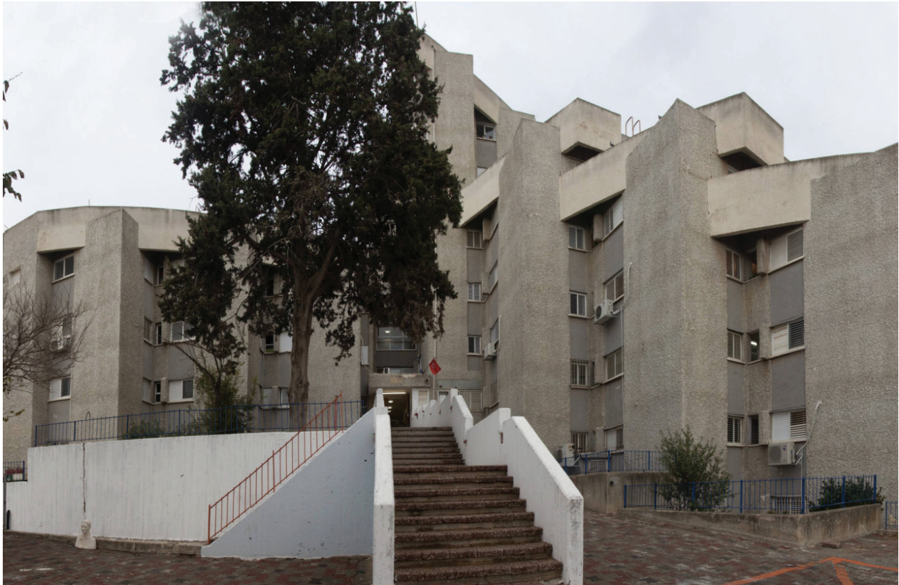
Kibbutz Mishol, Vista esterna
