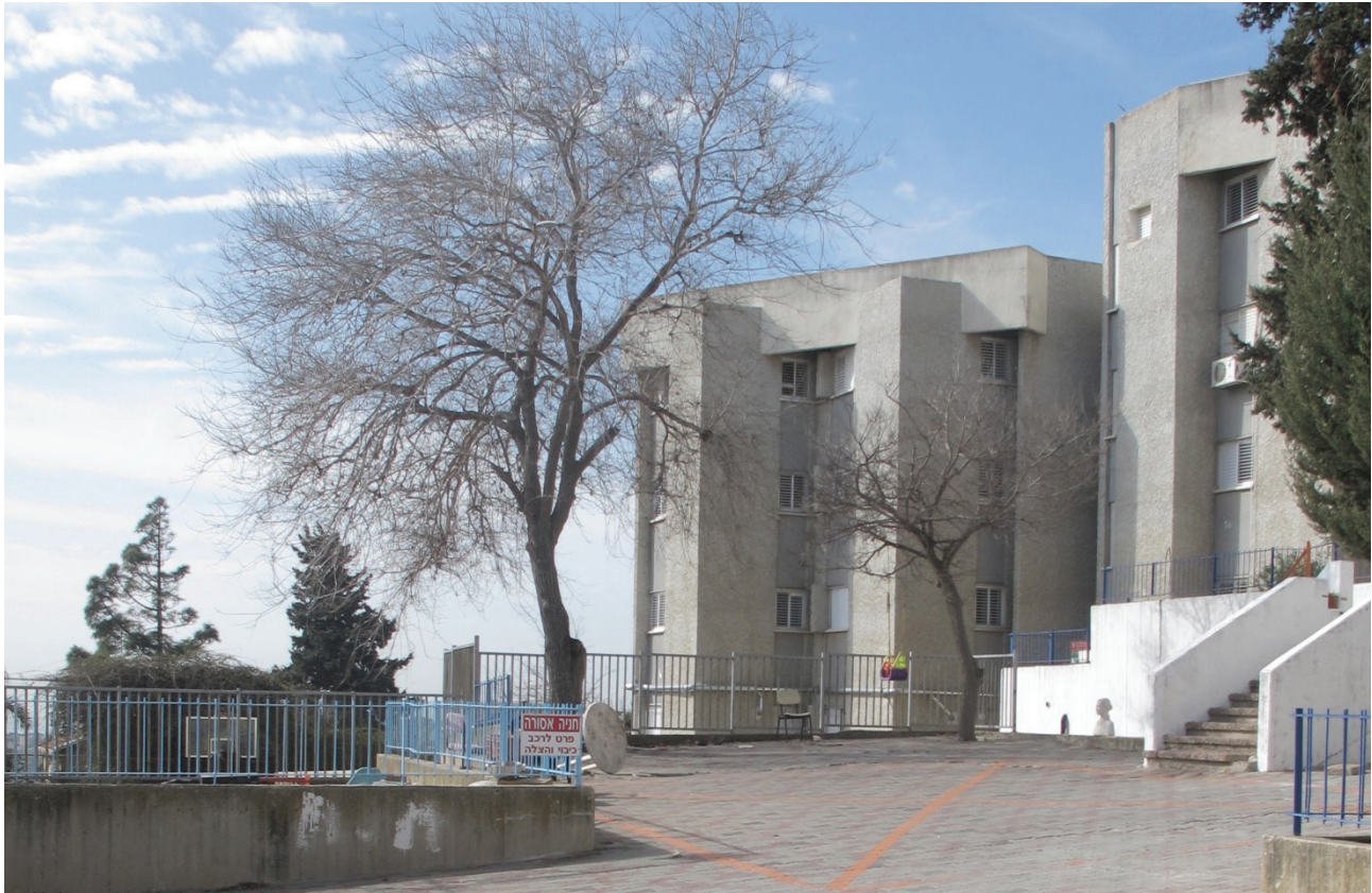
Kibbutz Mishol, Vista esterna
