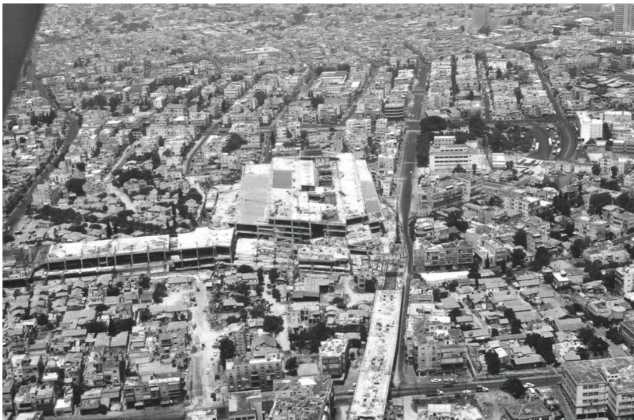
La Stazione centrale in costruzione, 1973 ( http://www.haaretz.co.il/gallery/architecture/.premium-1.2081113 )
