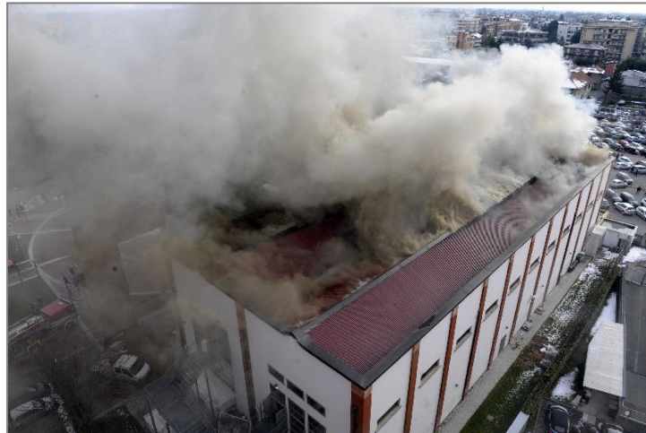
Figura 88: incendio del MAGA: vista dei fumi in copertura
