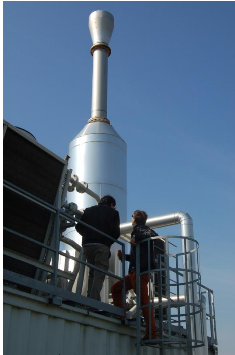
Fig. 78 Foto del camino dell'impianto a biogas Agrifer dove verrà installato il generatore termoelettrico.
