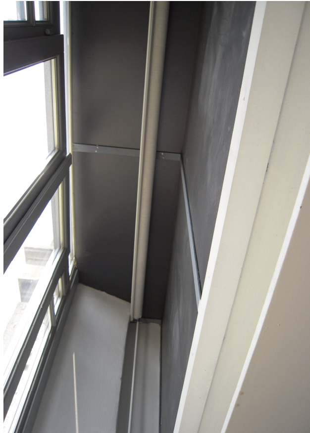
Figura 65 - Foto dal Piano Terra della soluzione interessata
