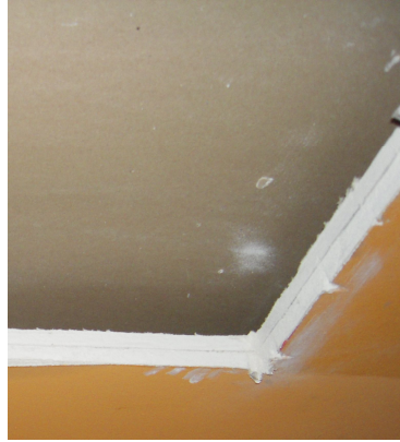
Figura 80 - Pannelli di cartongesso a doppia lastra
