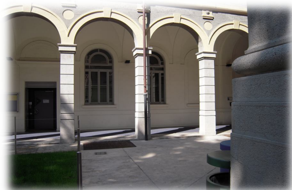
Figura 32 - Foto esterna dell'edificio interessato
