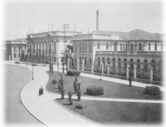
Figura 20 – Foto storica degli edifici affacciati su piazzale Leonardo da Vinci (fine anni '30)
