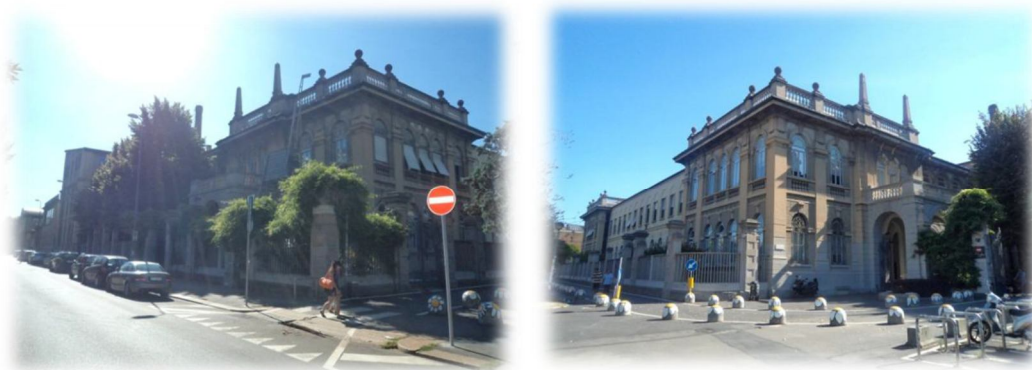
Figura 22 - Foto stato attuale da piazzale Leonardo da Vinci
