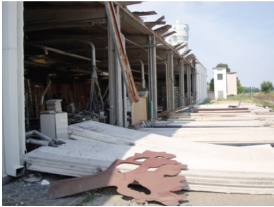
Figura 8: Ribaltamento fuori piano dei pannelli verticali
