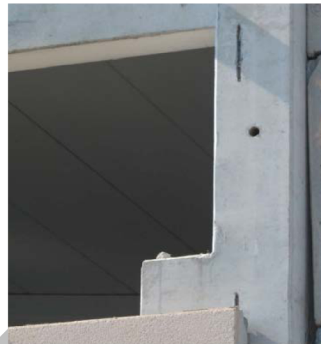
Figura 10: Collasso pannello orizzontale superiore
