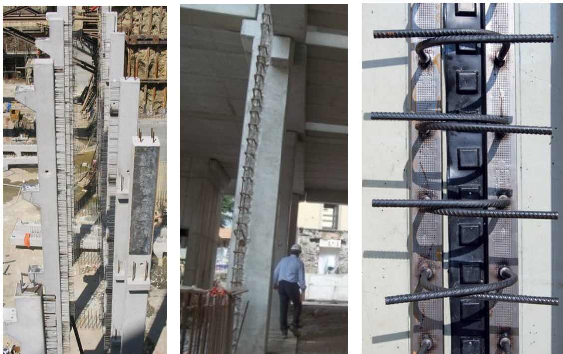
Figura 73: Riprese di getto tra pilastro prefabbricato e parete in opera
