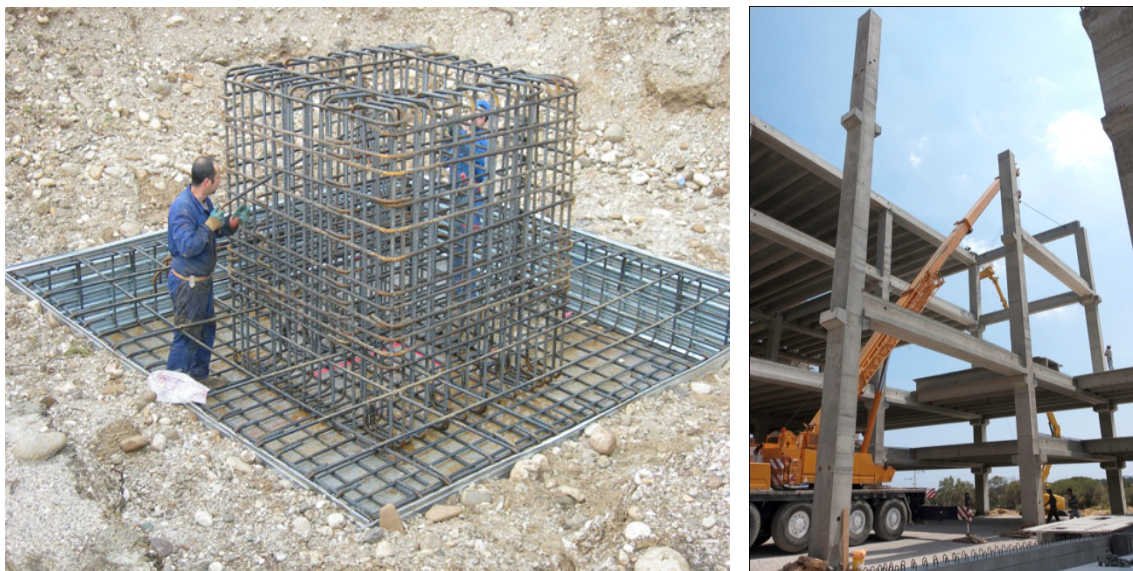
Figura 18: Plinto a pozzetto gettato in opera e telaio prefabbricato
