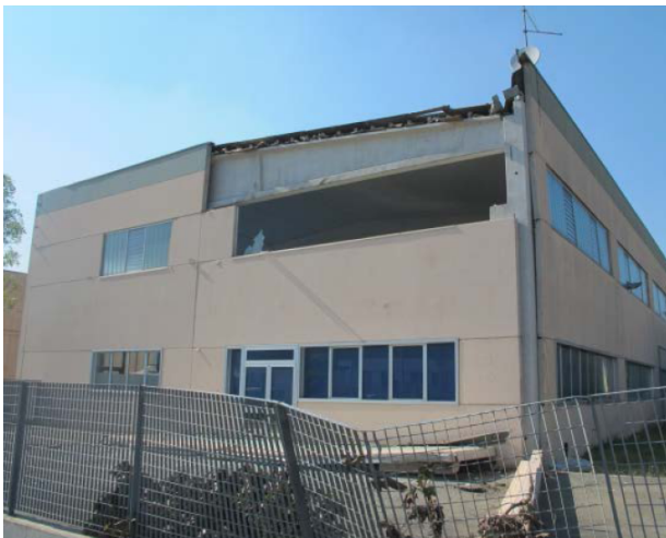
Figura 10: Collasso pannello orizzontale superiore
