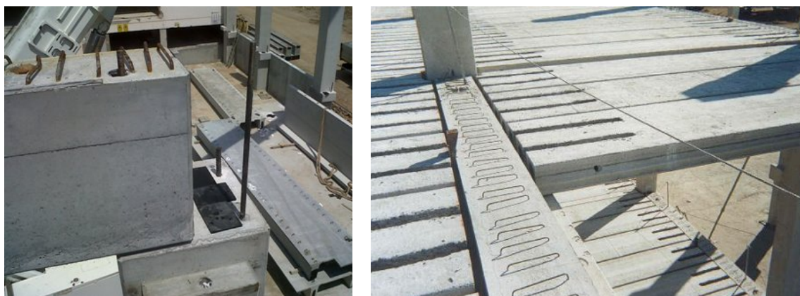
Figura 19: Dettagli di connessione trave-pilastro e solaio alveolare-trave
