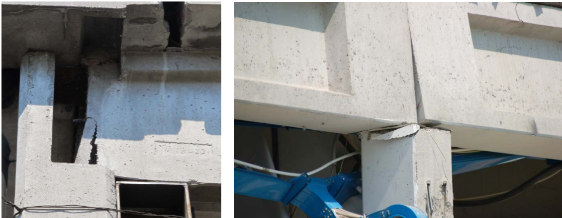
Figura 7: Scorrimento e ribaltamento della trave
