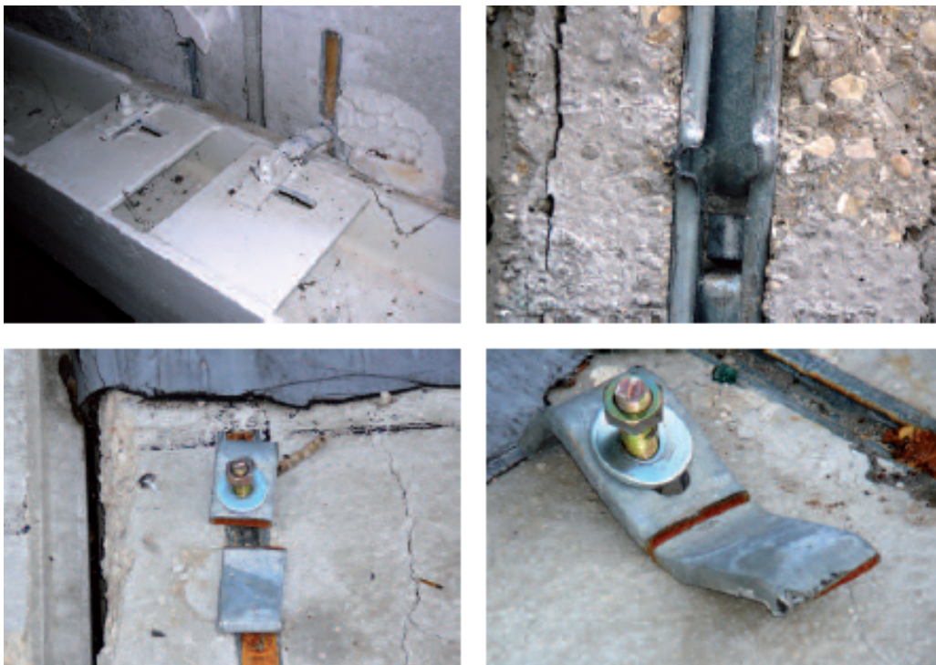
Figura 12: Meccanismi di rottura delle connessioni pannello-struttura
