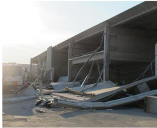
Figura 8: Ribaltamento fuori piano dei pannelli verticali
