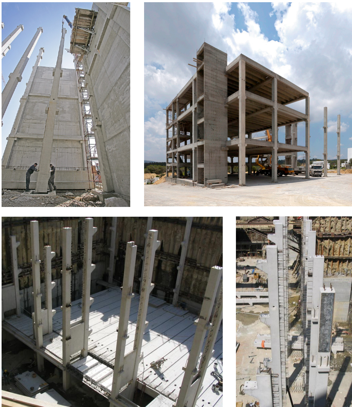
Figura 68: Edifici con sistema strutturale misto pareti-pilastri
