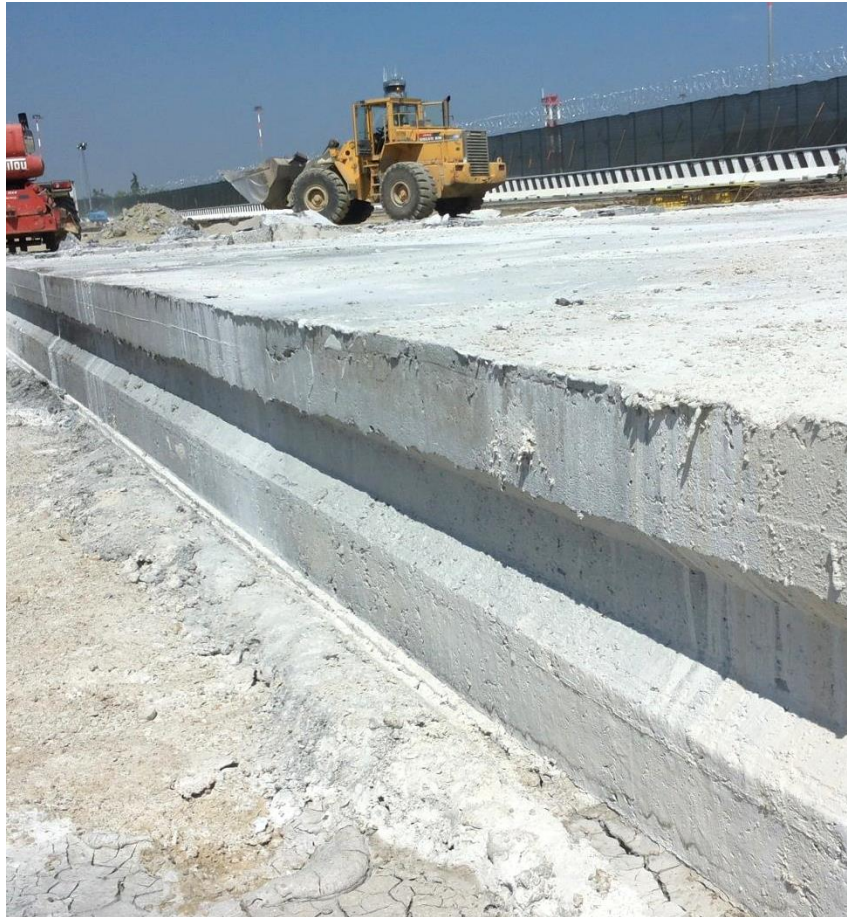
Figura 2.3 Giunto di costruzione longitudinale.
