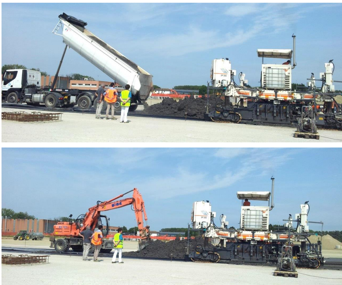
Figura 4.6 Approvvigionamento di calcestruzzo alla slip-form in cantiere.
