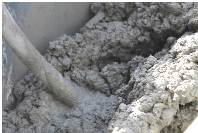
Figura 2.21 Effetto della vibrazione sul calcestruzzo.
