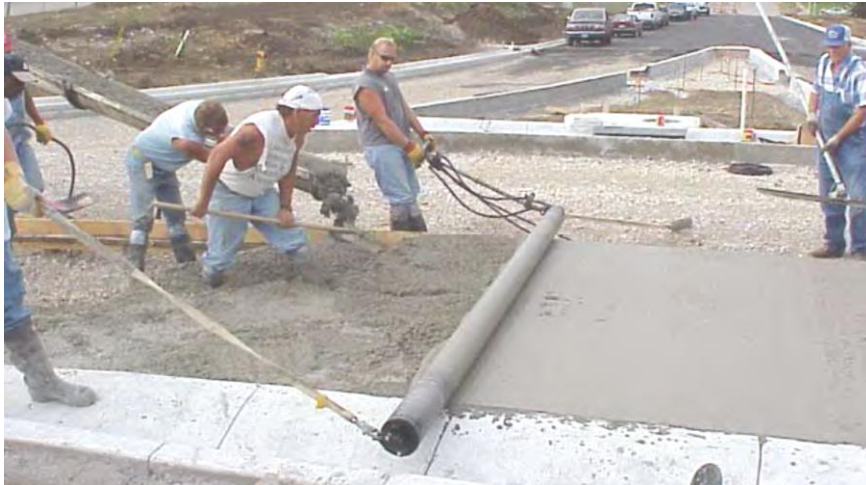
Figura 2.7 Getto di pavimentazione in cassaforma fissa compattata con rullo vibrante.
