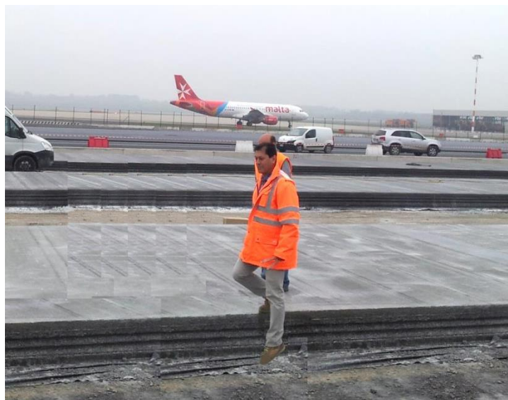
Figura 2.15 Esempio di pavimentazione realizzata con slip-form nell'area cargo dell'aeroporto di Malpensa.
