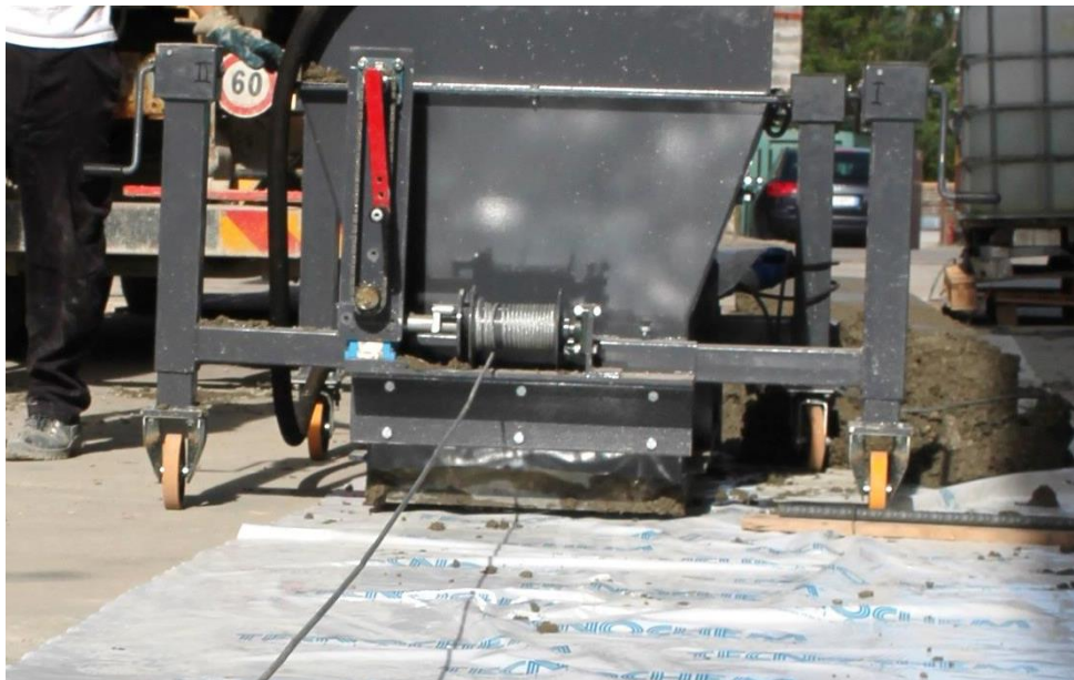
Figura 4.5 Verricello per l'avanzamento del cassero sperimentale.
