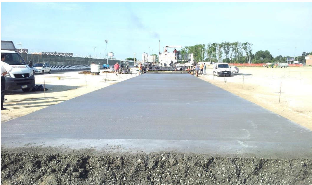
Figura 2.8 Estrusione della lastra mediante slip-form.
