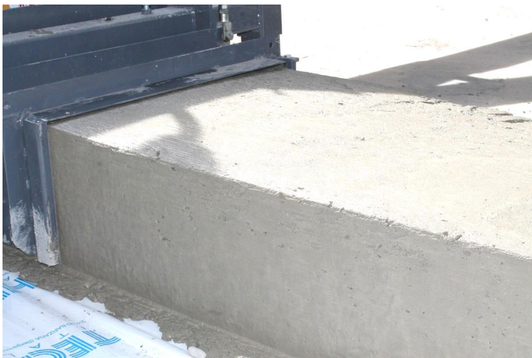
Figura 4.9 Finitura superficiale della lastra stesa con cassero sperimentale.
