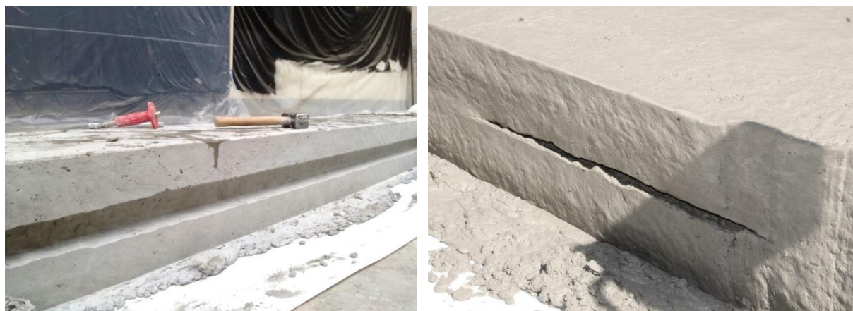
Figura G.4 Cordolo ben realizzato (a sinistra) e cordolo richiuso (a destra).
