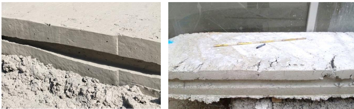
Figura G.5 Abbassamento del cordolo (a sinistra) e strappi nel cordolo (a destra).
