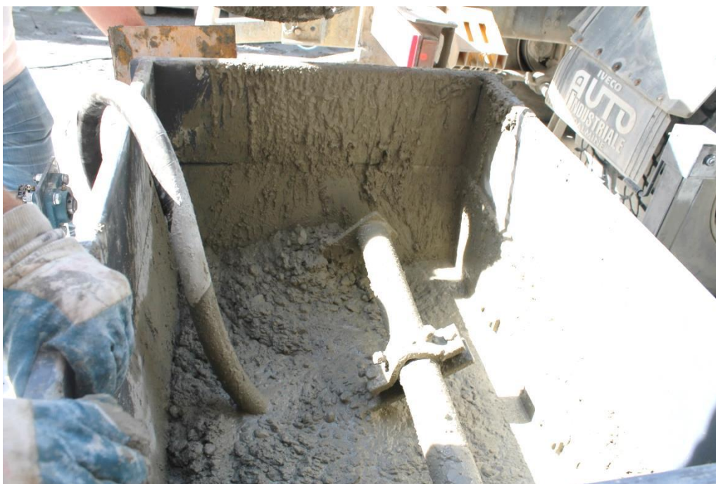
Figura 4.8 Vibrazione del calcestruzzo in fase di getto.
