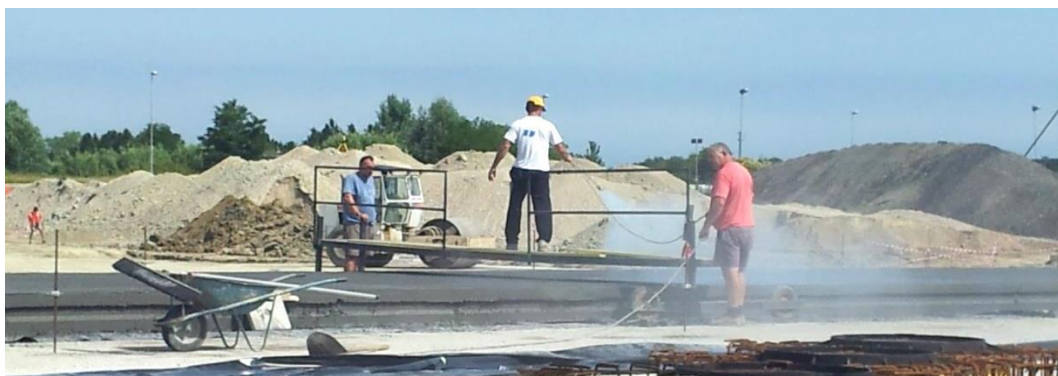
Figura 2.14 Spruzzatura del composto polimerico a protezione del getto.
