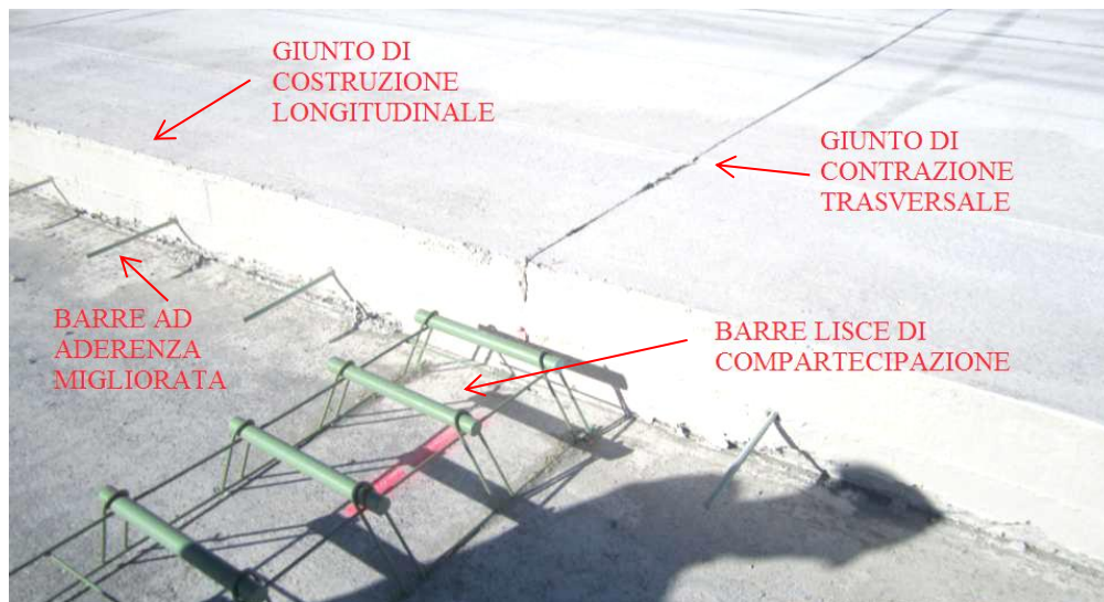
Figura 2.5 Giunti e barre di compartecipazione.
