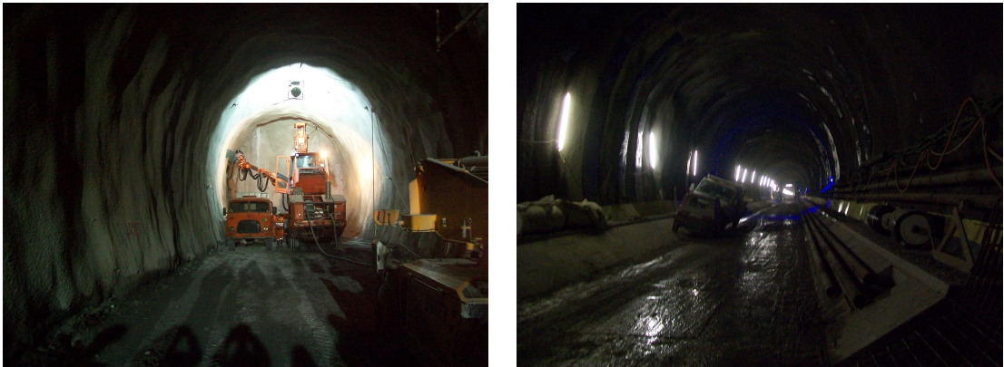
Figura 6.5: Cantiere della Galleria di base del Monte Ceneri (foto degli autori).
