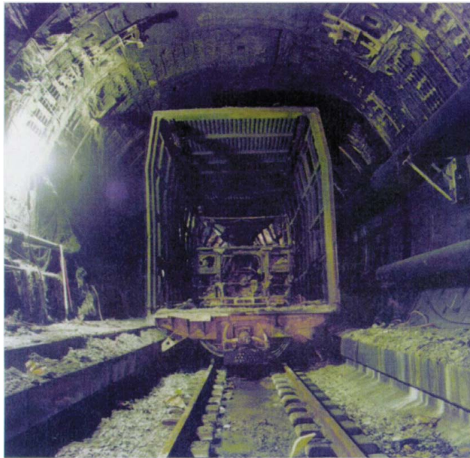
Figura 1.2: Conseguenze dell'incendio nel Channel Tunnel, Novembre 1996 (foto da Eurotunnel/QA Photos Ltd.)
