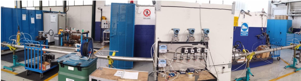
Figura 2.4: L'impianto Flow Lab Gas
