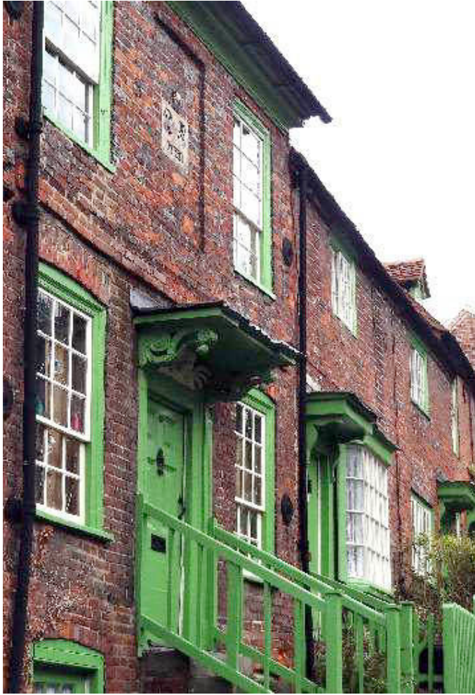
Fig. 22 Facciata in mattoni
