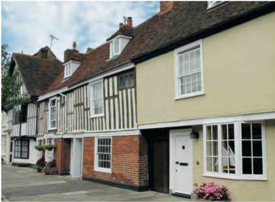
Fig. 20 Tipica casa inglese del XVIII secolo con facciata in parte in mattoni e in parte in legno
