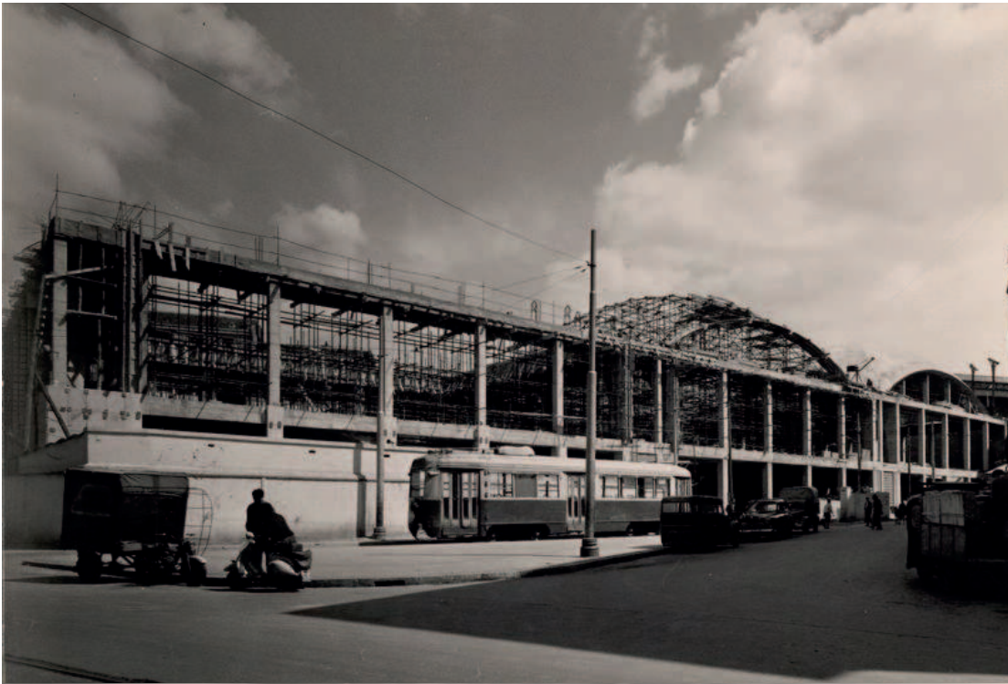
16-17: Il mercato durante il 1956 in costruzione.
