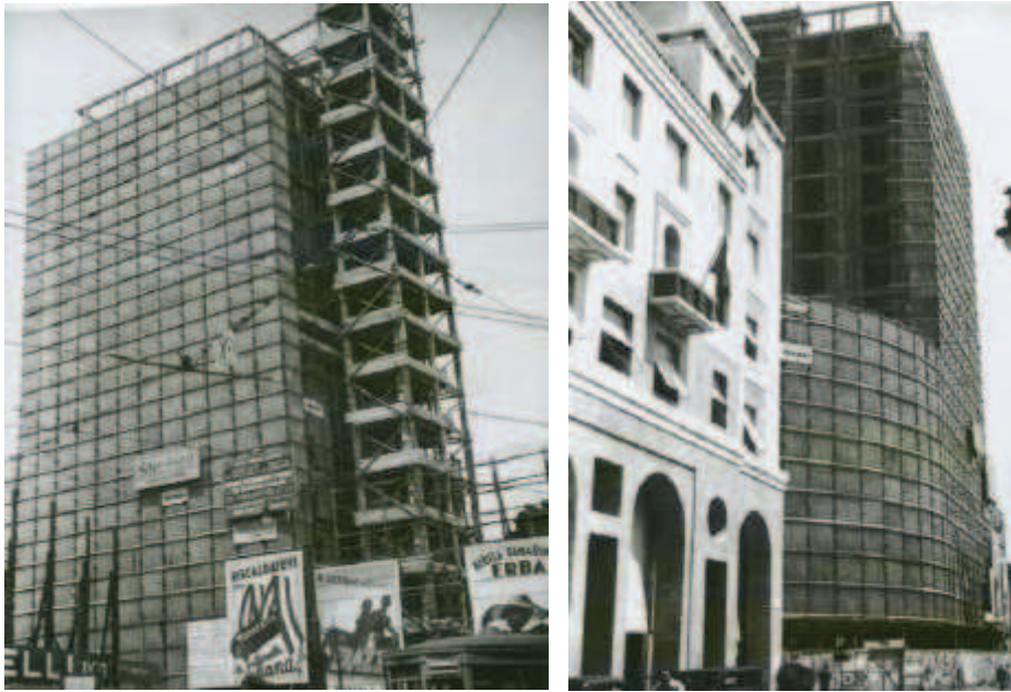
Torre Snia Viscosa, fasi costruttive, 1936
