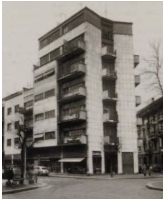
Casa Ghiringhelli, fotografie storiche su p.za Morbegno prima e dopo la sopraelevazione e l'applicazione delle borchie di fissaggio
