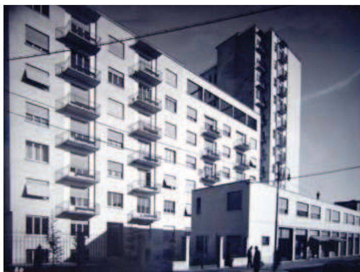
Condominio per abitazioni, uffici e negozi in via M. Gioia 1, foto d'epoca, anni '50
