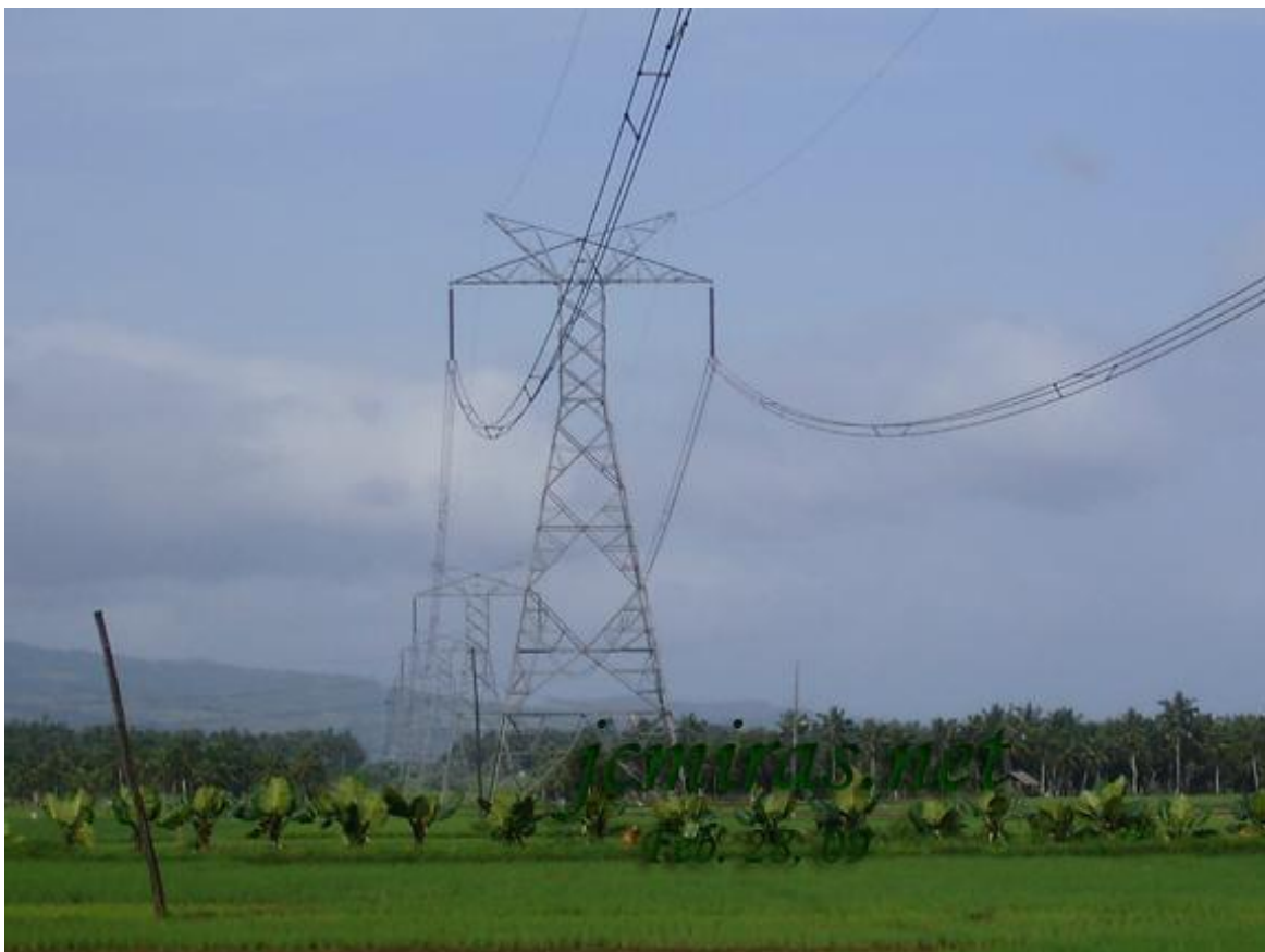
Figura 5 - Linea aerea dell'impianto HVDC Leyte - Luzon (Filippine)
