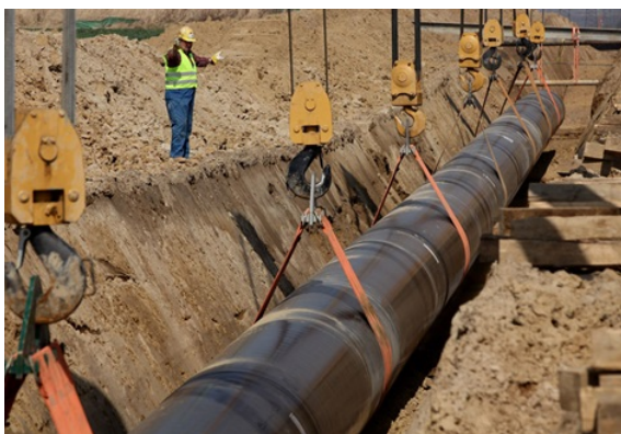
Figura 2.5: Posa delle condotte Fonte: Enciclopedia degli idrocarburi
