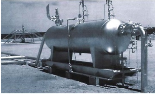
Figura 3.10: Separatore orizzontale Fonte: Enciclopedia degli idrocarburi
