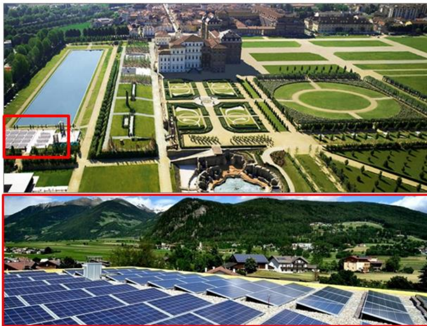
Figura 35: Installazione di pannelli fotovoltaici a servizio di una villa tutelata di Brunico.
