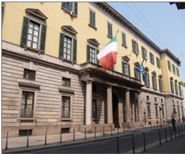
Figura 1: Palazzo storico di Milano che riassume alcune tra le caratteristiche peculiari dell'edilizia milanese; l'intonaco giallo Milano, la cornice grigia attorno ai serramenti, il piano terra bugnato.
