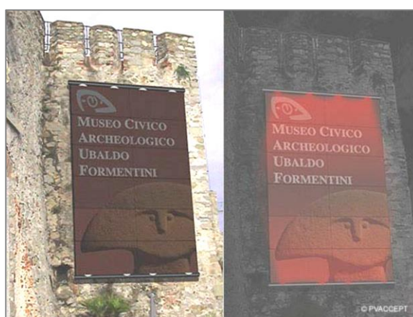
Figura 32: Pannello solare informativo del Castello di San Giorgio, La Spezia. [Fonte: PVaccept Final Report]
