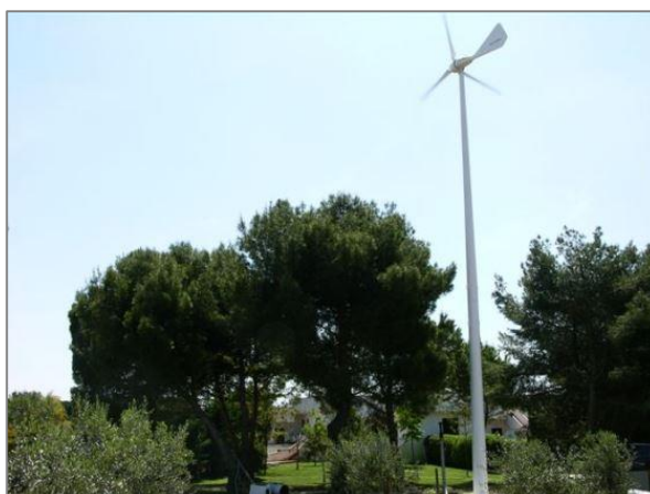
Figura 42: Turbina mini eolica, Crispiano (TA).
