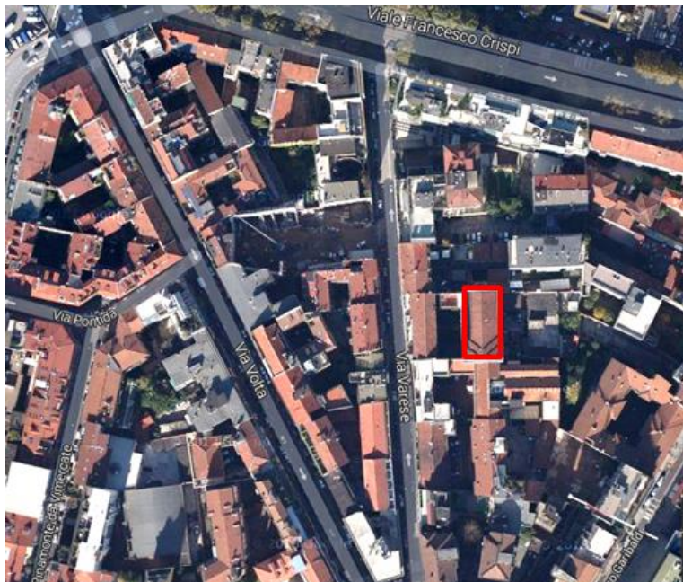
Figura 50: Inquadramento del fabbricato in esame. [Fonte: Google Maps]
