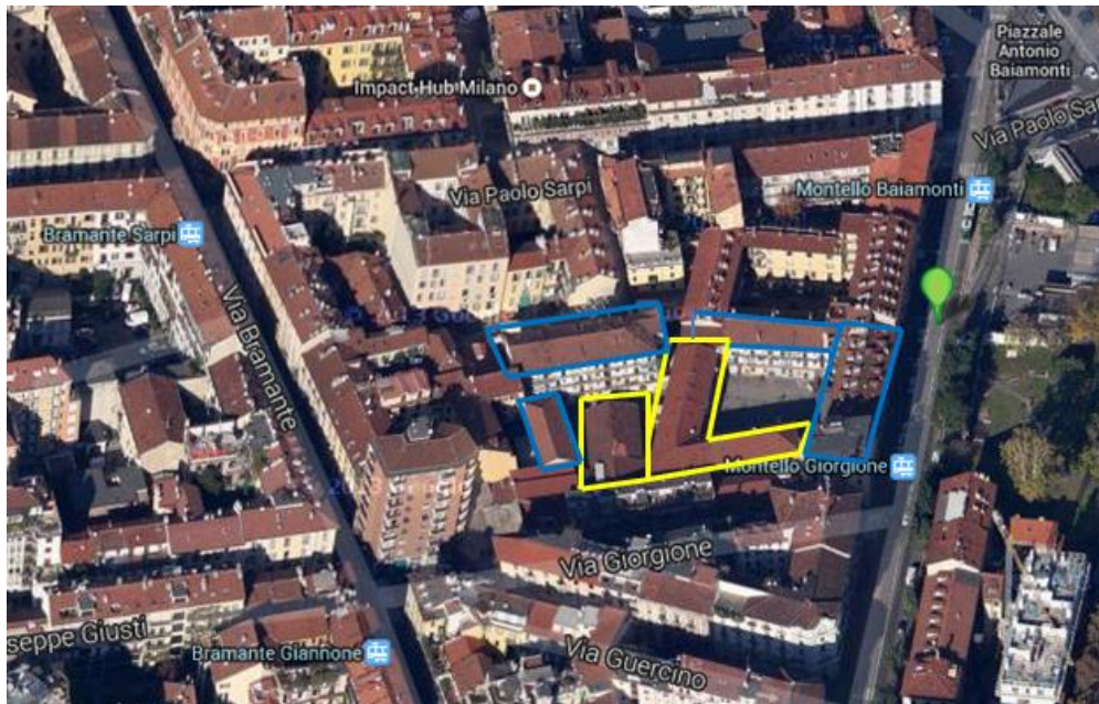
Figura 72: Identificazione dei fabbricati: si evidenziano in blu quelli ristrutturati, in giallo quelli sottoposti a sostituzione edilizia. Il pallino verde indica Viale Montello.
