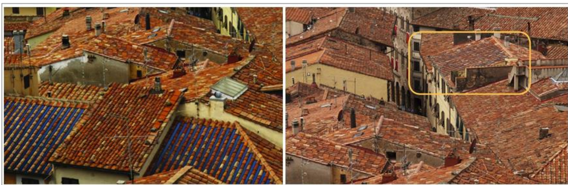
Figura 30: Integrazione impiantistica a basso impatto visivo di un impianto fotovoltaico.
