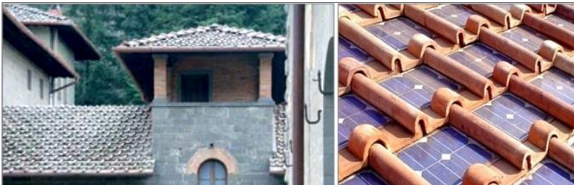
Figura 29: Tegole fotovoltaiche. Esterno del Castello di Acquabella, Firenze, e dettaglio delle tegole.
