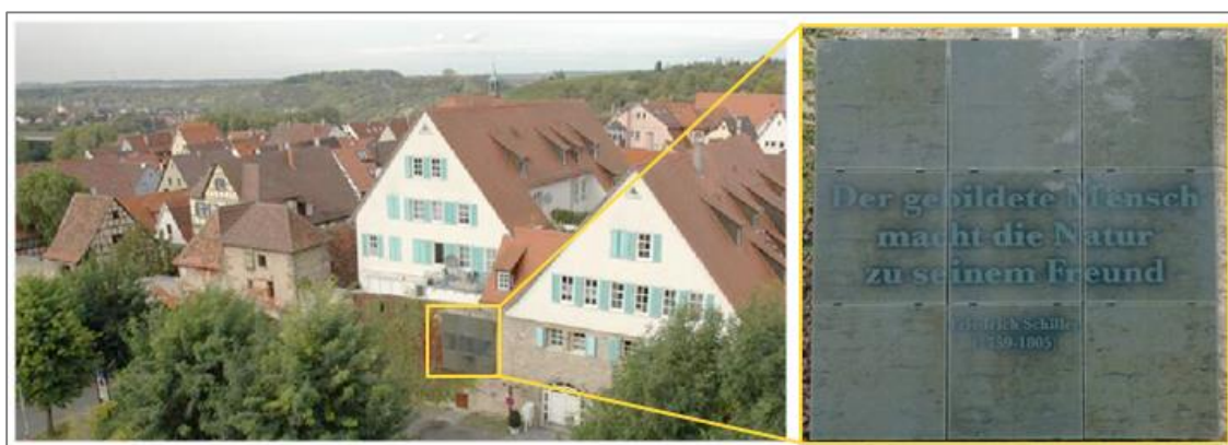
Figura 31a: Vista panoramica di un muro storico con ingrandimento del pannello-insegna. Città di Marbach am Neckar. [Fonte: Composizione immagini fornite da PVaccept Final Report].
