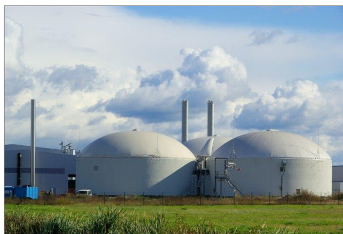
Figura 15: Esempio di impianto a biomasse.
