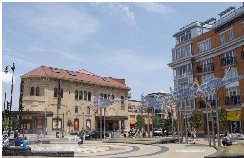
Figura 37: Installazione di pensiline fotovoltaiche, piazza Columbia, Washington.
