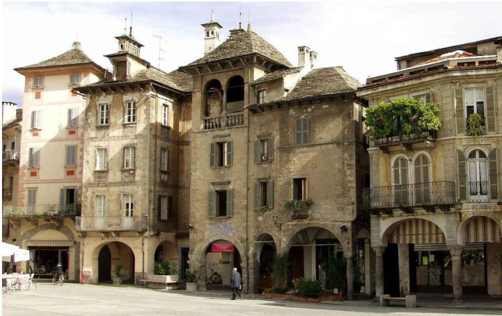
Figura 8: Edifici storici di Domodossola.
