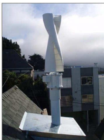
Figura 45: Esempio di pala micro-eolica ad asse verticale ad uso domestico.
