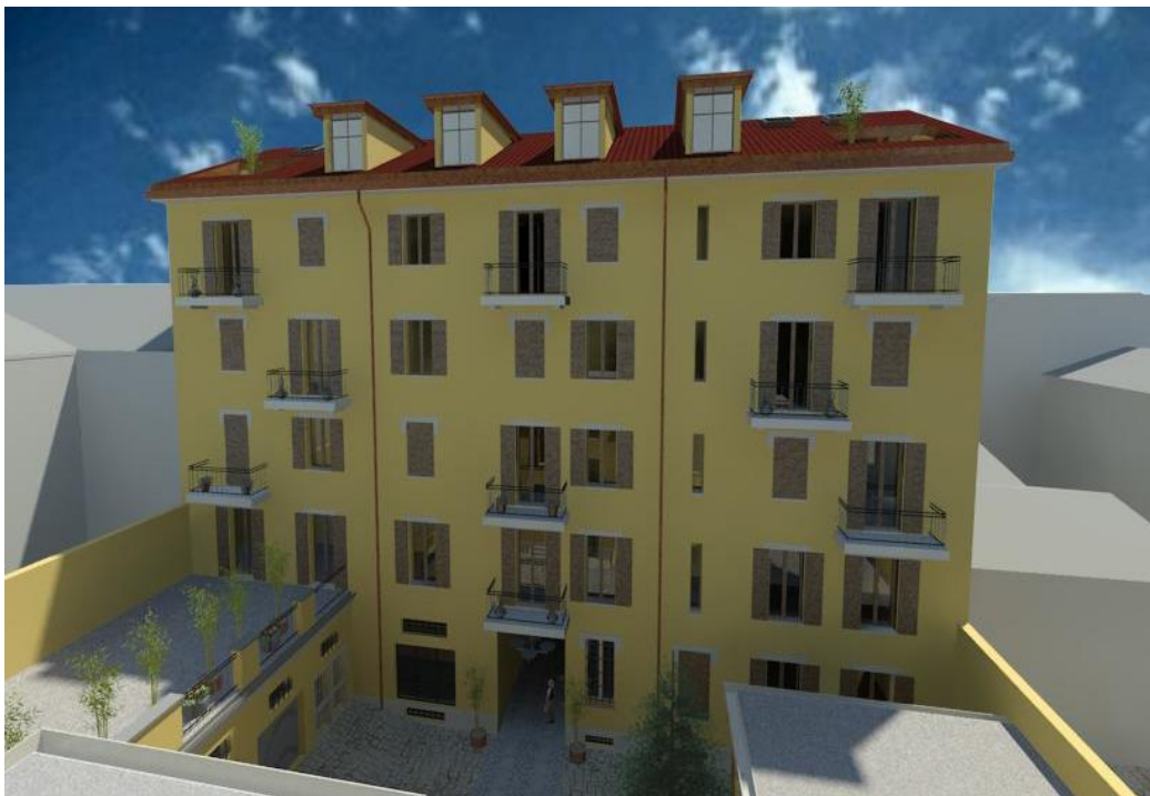
Figura 58: Vista dal basso dell'intervento.
