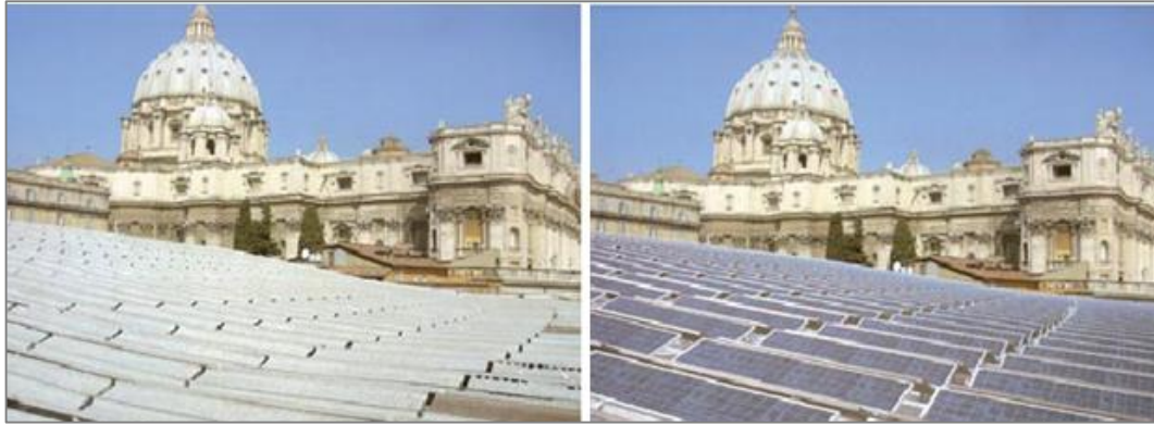
Figura 33: La copertura dell'edificio prima e dopo l'installazione dei pannelli fotovoltaici. Sala Nervi in Vaticano.
