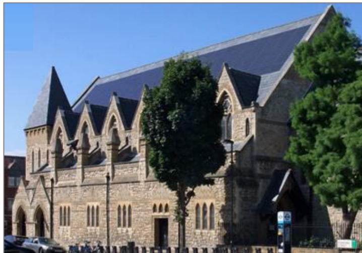
Figura 34: St. Saints Silas Church, Pentonville, London. Esempio di installazione integrata di pannelli fotovoltaici.
