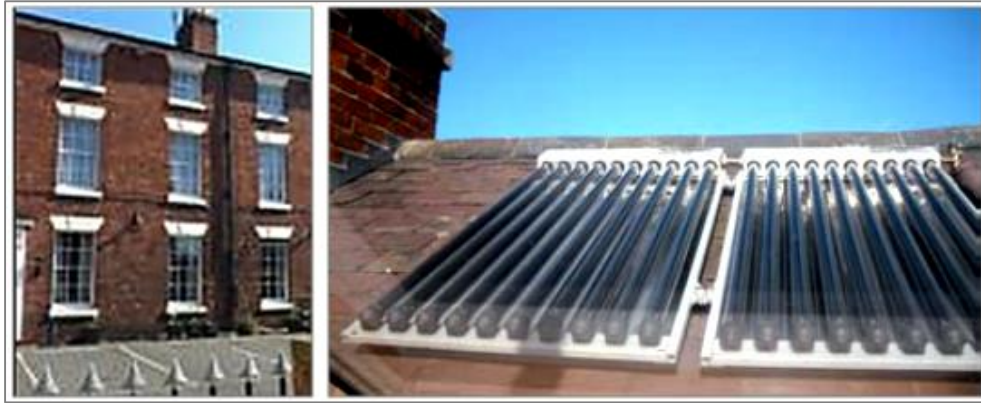
Figura 40: Casa georgiana vincolata nel centro storico di Shrewsbury, UK. Applicazione di un impianto solare termico. [Fonte: Progetto SECHURBA]
