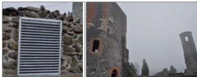
Figura 46: Castello di RacBath, Budapest. Installazione di pompa di calore ad acqua. [Fonte: progetto SECHURBA]
