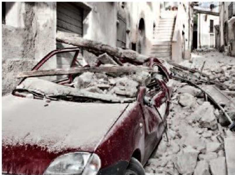
Figura 1-2 – Effetti secondari Espulsione murature, L'Aquila, 2009
