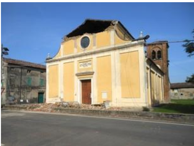
Figura 49 - Chiesa della Visitazione della Beata Vergine Maria dopo il sisma del 2012 - Rif. Bibliog. [10]
