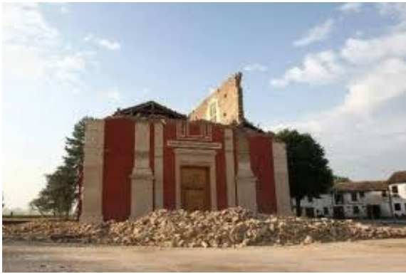
Figura 105 - Chiesa di S. Martino di Tour dopo il sisma del 2012 - Rif. Bibliog. 28
