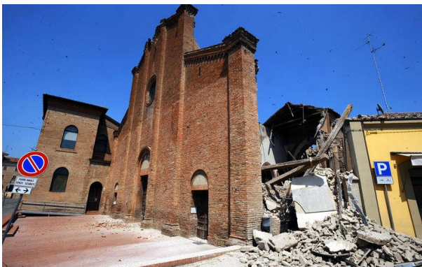
Figura 121 - Effetti del "nave transversal response", duomo di Mirandola - Rif. Bibliog. [10]
