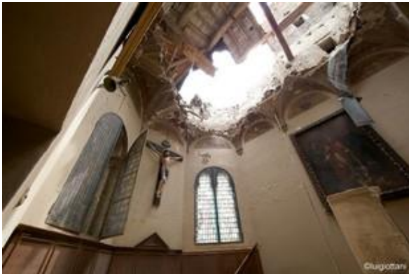
Figura 11 - Copertura del presbiterio della Chiesa di S. Caterina dopo il sisma del 29 maggio 2012 - Rif. Bibliog. [10]
