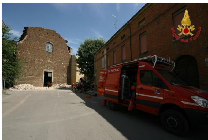
Figura 19 - facciata della Chiesa del Gesù in seguito al sisma del maggio 2012 - Rif. Bibliog. [14]
