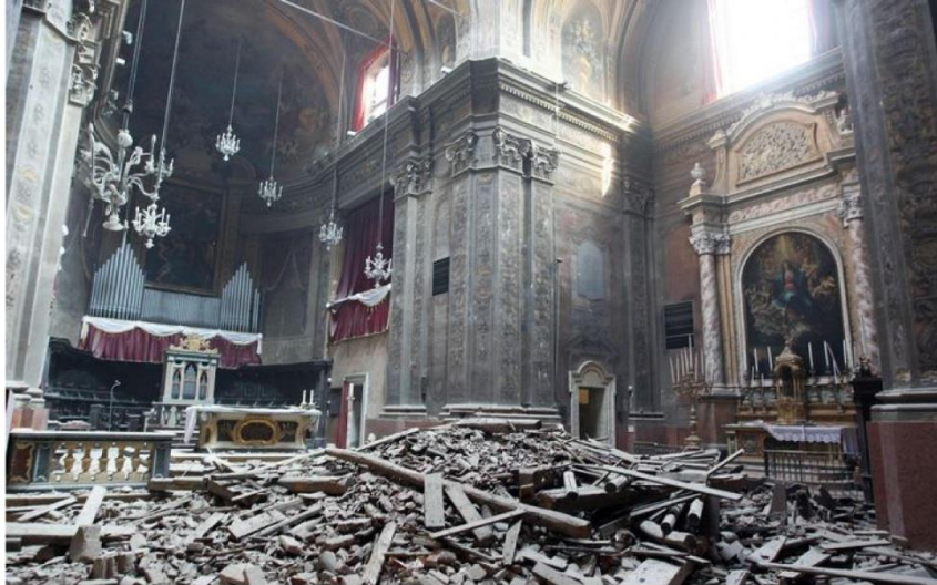
Interno, dopo il sisma del 29 Maggio
