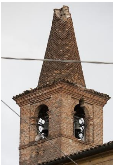
Figura 7 - Campanile della chiesa di S. Caterina dopo il sisma del 20 maggio 2012 - Rif. Bibliog. 01
