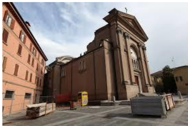
Figura 85 - Chiesa di S. Egidio dopo il sisma del maggio 2012 - Rif. Bibliog. [29]
