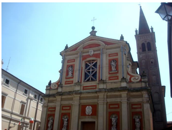
Figura 117 - Chiesa di S. Maria Maggiore prima del sisma del maggio 2012 - Rif. Bibliog. [45]
