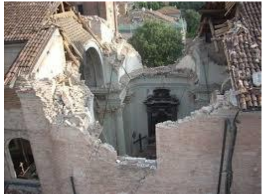
Figura 69 - Copertura della Chiesa di S. Possidonio dopo il sisma del 2012 - Rif. Bibliog. 01
