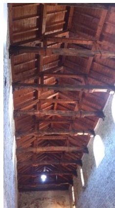
Figura 143 - Copertura della navata centrale della collegiata di S. Vittore - Rif. Bibliog. [69]
