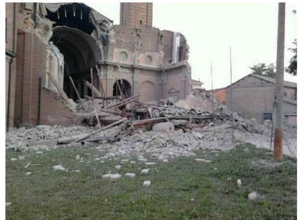
Figura 101 - Abside della Chiesa di S. Paolo dopo il sisma del 2012 - Rif. Bibliog. [35]
