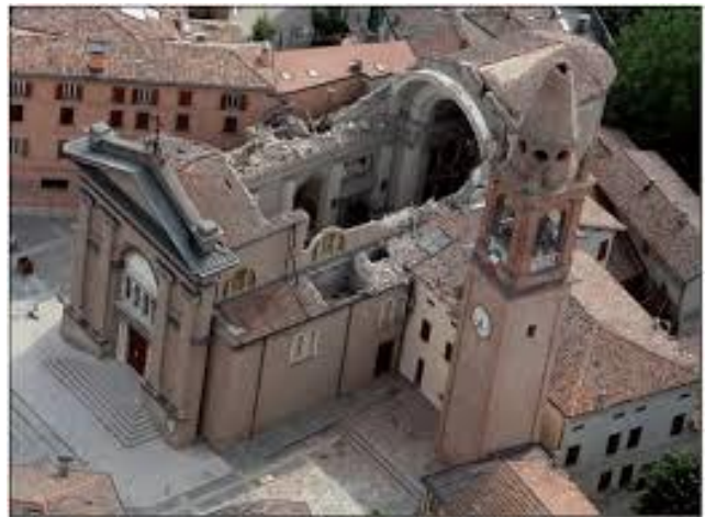
Figura 87 - Chiesa di S. Egidio dopo il sisma del maggio 2012 - Rif. Bibliog. [29]
