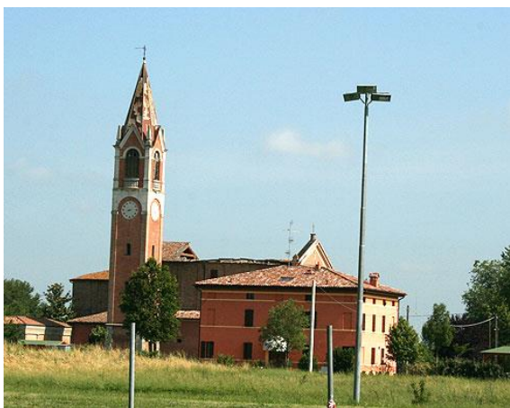
Figura 64 - Chiesa madre, crollo della copertura - Rif. Bibliog. [10]
