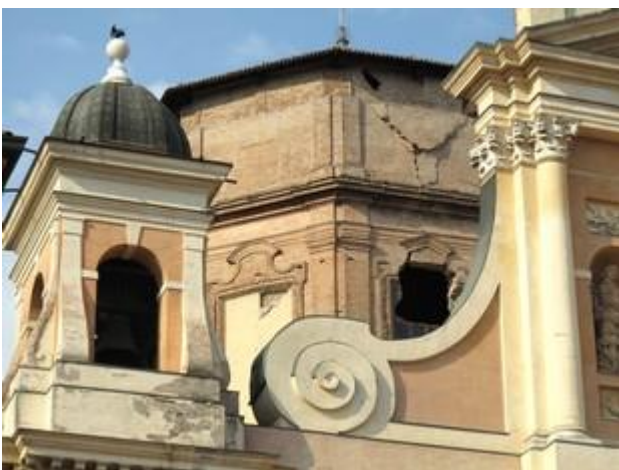
Figura 57 - Lesioni alla cupola del Duomo di Carpi dopo il sisma del 20 maggio 2012 - Rif. Bibliog. [10]
