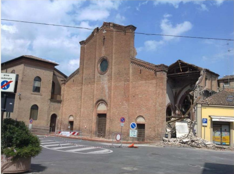
Chiesa di San Francesco dopo il terremoto
