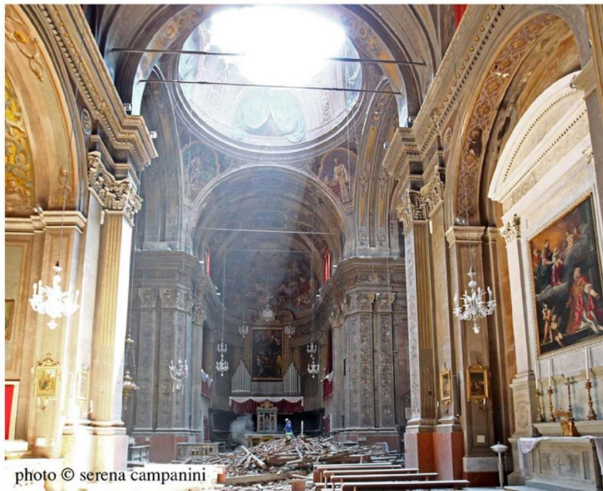
Interno, dopo il sisma del 29 Maggio
