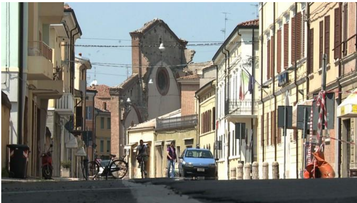
Figura 27 - Chiesa di S. Francesco dopo il sisma del maggio 2012 - Rif. Bibliog. [22]
