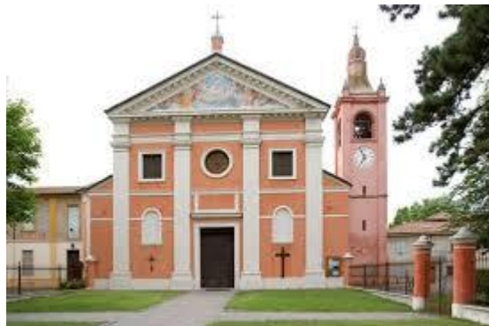
Figura 76 - Chiesa della Natività di S. Maria prima del sisma del 2012 - Rif. Bibliog. [27]
