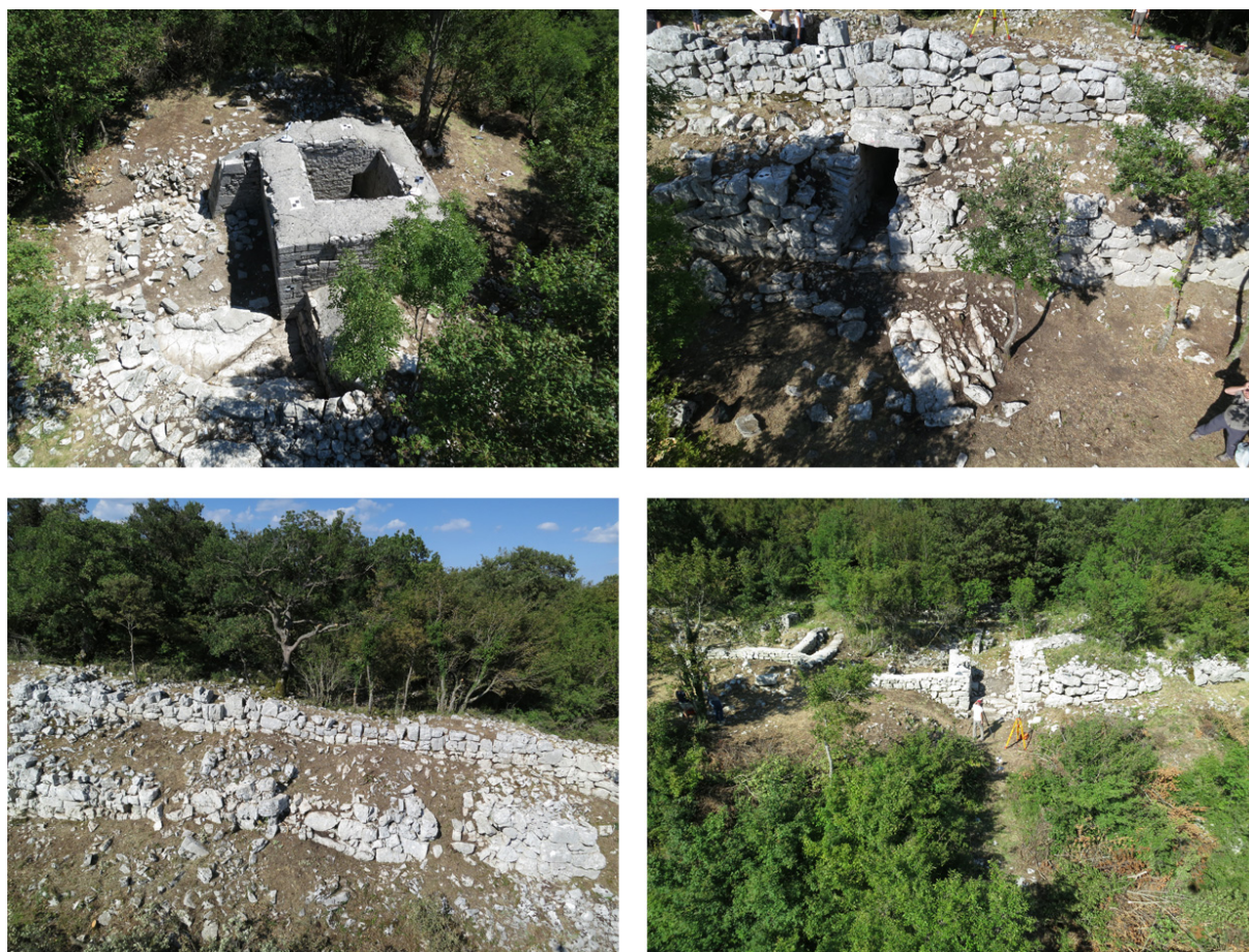
Figura 28: Monumenti del sito rilevati. In alto a sinistra: la cosiddetta torre rettangolare; in alto a destra: la Postierla del Matese; in basso a destra: la Porta Medievale; in basso a sinistra: le mura sannitiche.
