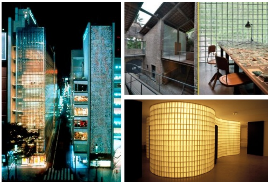
Figura 1: Esempi di utilizzo del vetro mattone. In senso orario - R. Piano, Maison Hermes , Tokyo, 1998 – 2006 – Scorcio dell'ex fabbrica Rolla, Parco delle Gole del Breggia, Svizzera – interno del Complesso Kursaal , Montecatini Terme (Pistoia), 2004.
