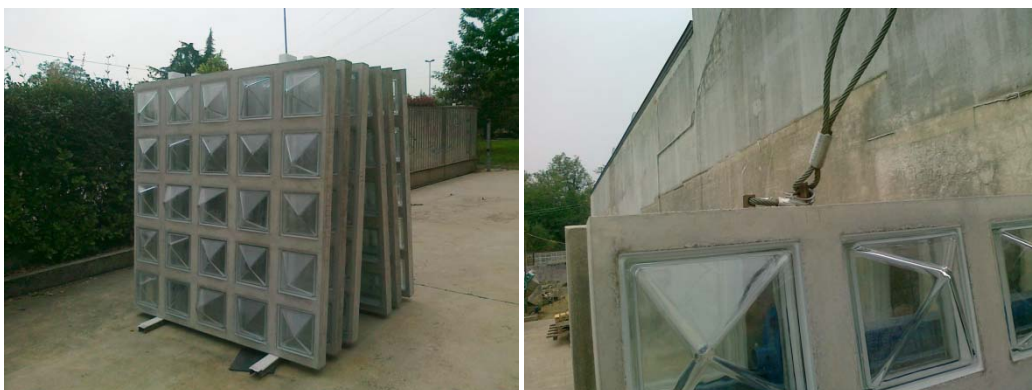
Figura 54: Posizionamento verticale dei pannelli.
