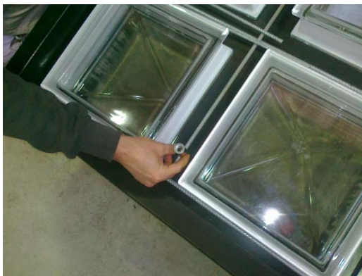
Figura 48: Dettaglio - Posizionamento boccole di fissaggio del pannello.
