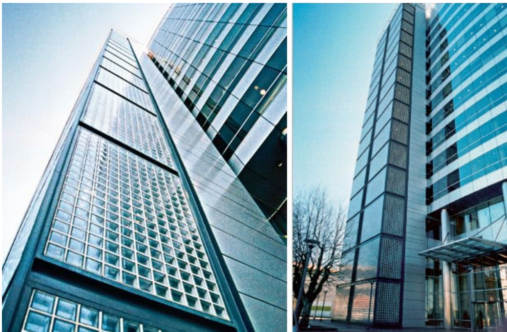
Figura 24: Edificio Malecòn, Particolari dei pannelli in vetrocemento.
