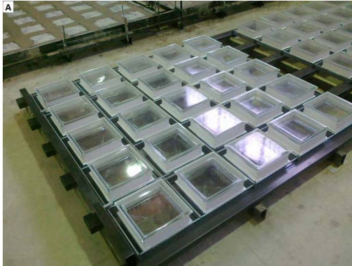
Figura 46: Fasi di preparazione al getto - Posizionamento mattoni, armature e sponde.
