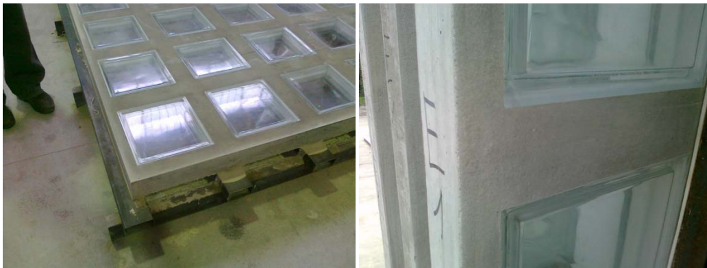
Figura 52: Dettaglio – Fine di maturazione del getto.
