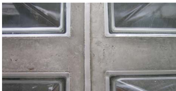
Figura 74: Giunto silconico tra i pannelli che compongono la facciata.
