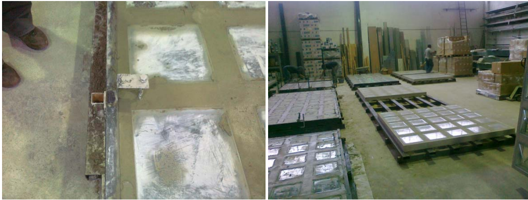
Figura 50: Dettaglio - Completamento getto superiore.
