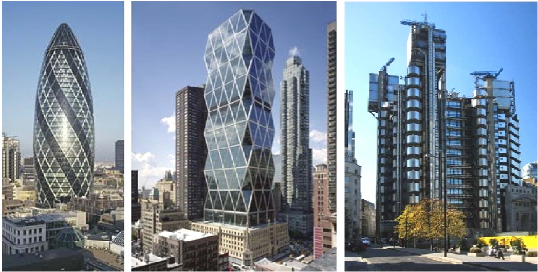
Figura 6: da sinistra - N. Foster, 30 st Mary Axe , Londra, 1997-2004 - N. Foster, Hearst Tower , New York, 2003-2006 - R. Rogers, Lloyd's Building , Londra, 1978-1986.
