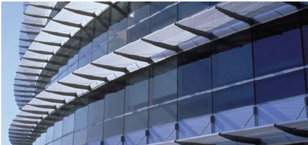
Figura 22: Edificio Malecòn. Particolare della facciata continua.
