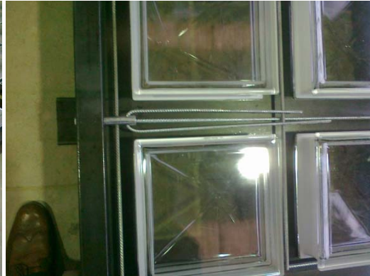
Figura 46: Fasi di preparazione al getto - Posizionamento mattoni, armature e sponde.
