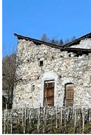
figura 3.7 costruzione in granito
