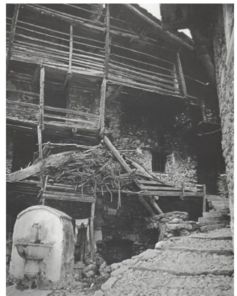
figura 3.19 veduta del fronte principale
