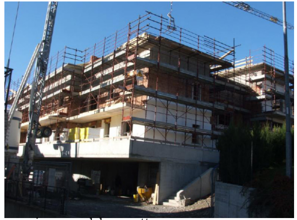
posa in opera del cappotto
