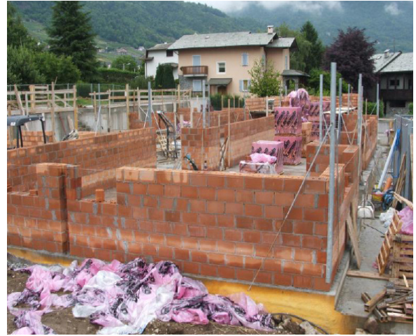
realizzazione murature in laterizio
