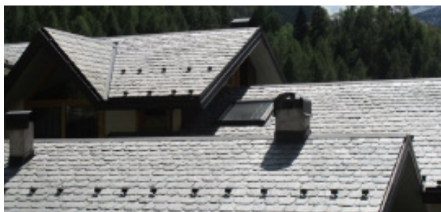
figura 3.5 lastre di serpentino tegolare per tetti
