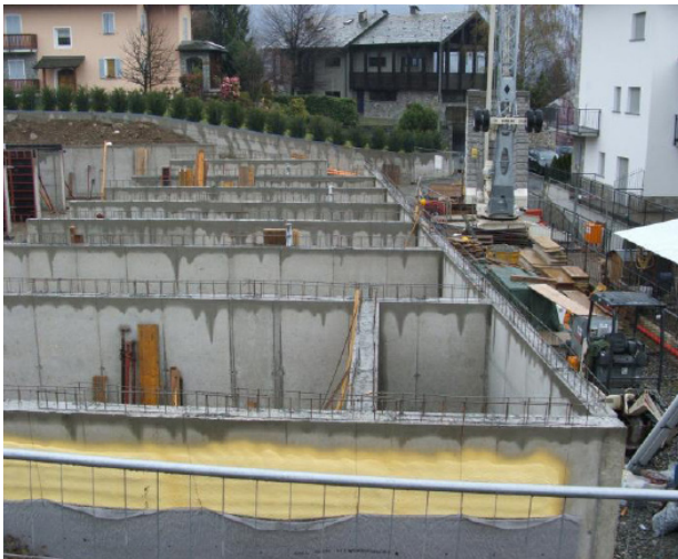
realizzazione parti in cemento armato
