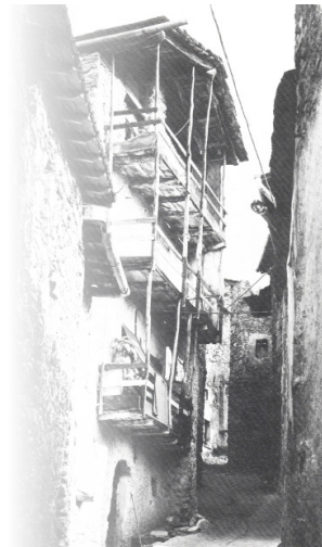
figura 3.9 ballatoio in legno a Cino
