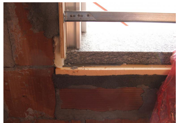
taglio termico del serramento
