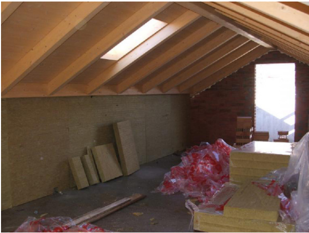
isolante in lana di roccia
