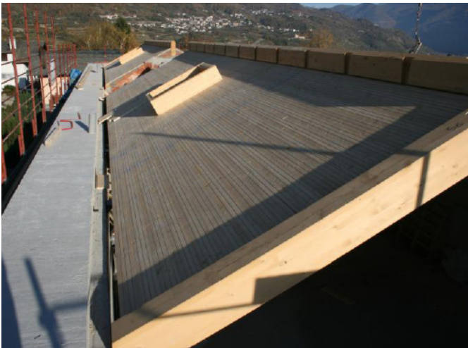
falda inclinata della copertura
