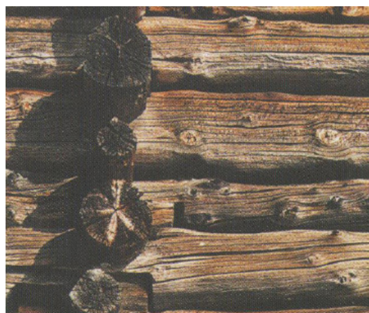
figura 3.60 particolare di un fienile a San Sisto
