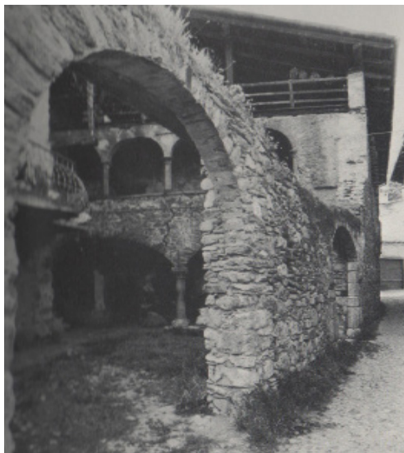
figura 3.12 edificio quattrocentesco a Ponte in Valtellina
