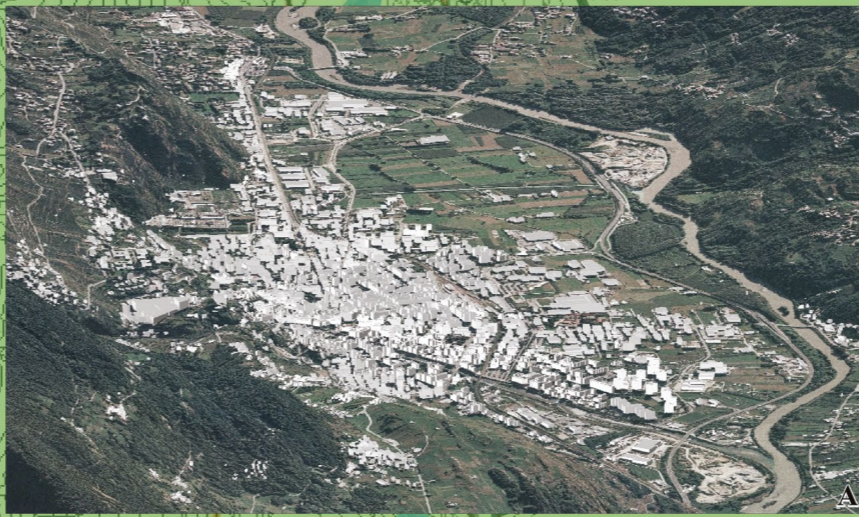
VISTA PANORAMICA A
