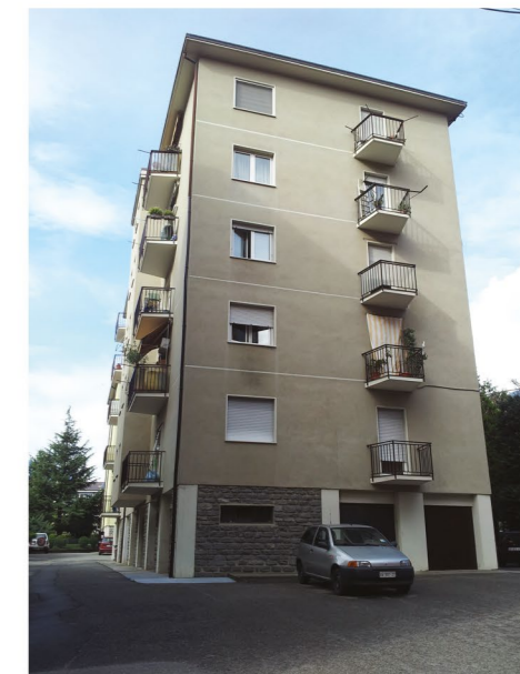
foto 5 prospetto ovest edificio 22
