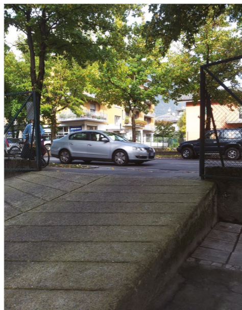
foto 2 rampa di accesso secondaria
