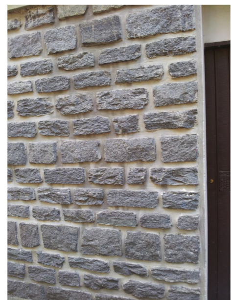
foto 7 muratura pietra a vista del piano terra
