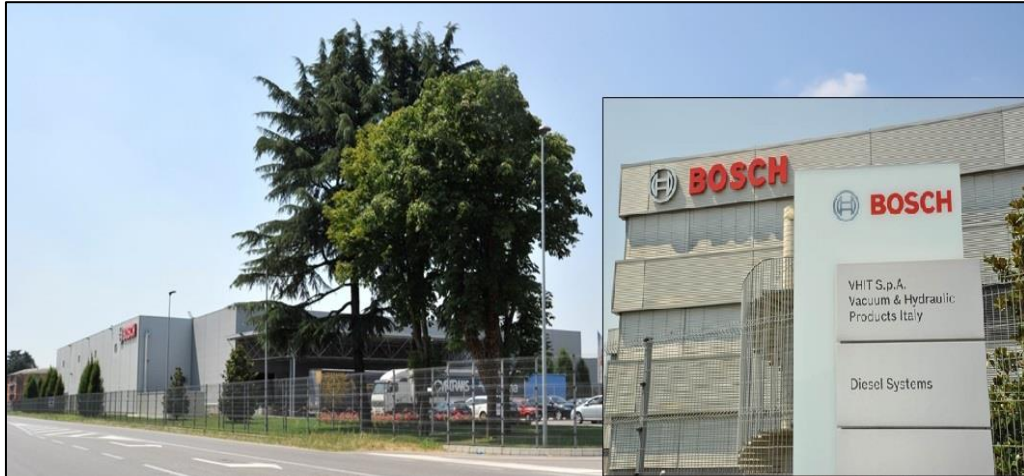
Figura 7. Vista esterna di VHIT e dettaglio dell'ingresso
