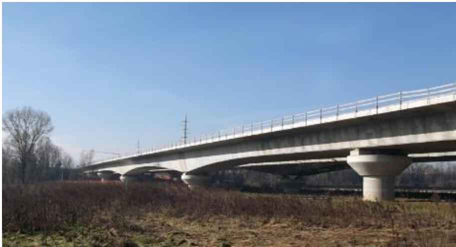
Figura 4.1: vista del viadotto Oglio.
