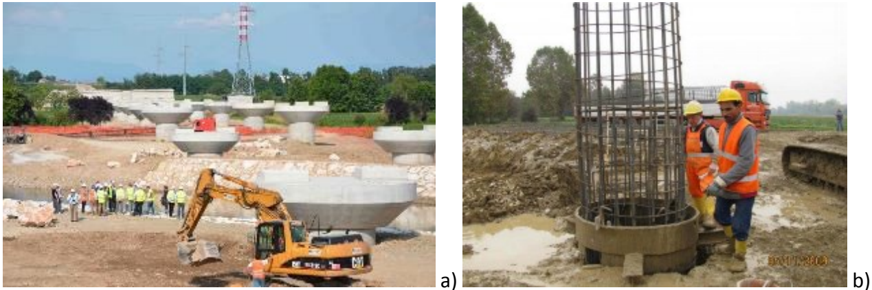
Figura 4.3: a) pile del viadotto Oglio; b) pali di fondazione delle pile.
