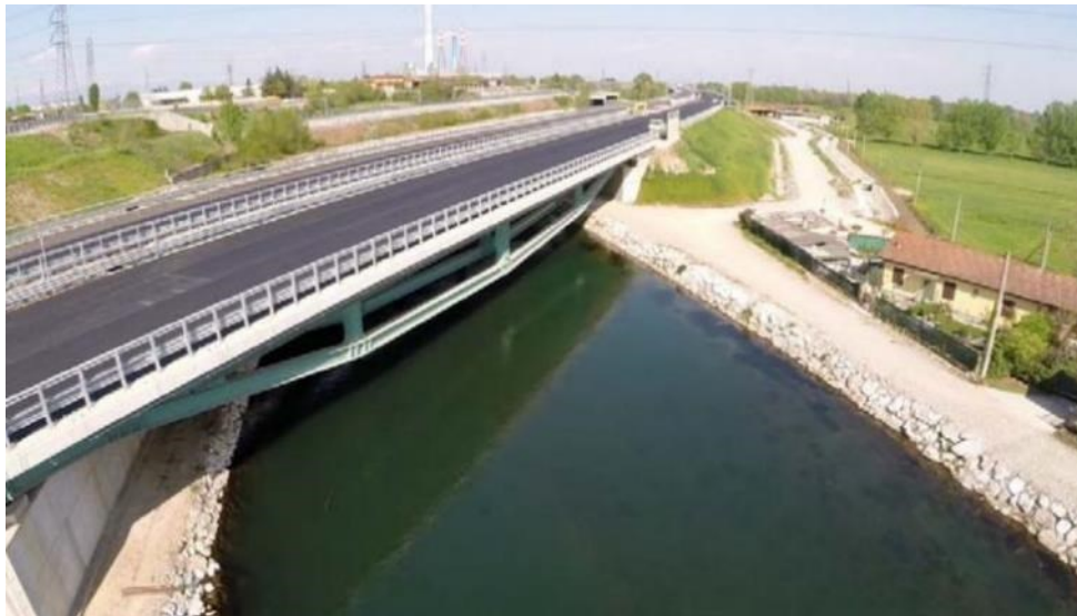
Figura 5.1: vista del ponte Muzza completato.
