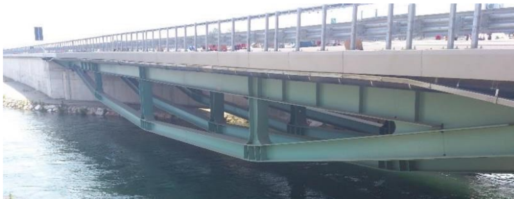
Figura 5.2: vista laterale del ponte Muzza. Sono ben visibili sia la struttura metallica di sostegno, sia la soletta in calcestruzzo armato.
