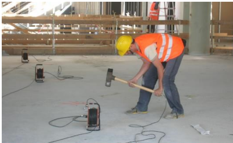
Figura 1.9: esempio di eccitazione impulsiva su una soletta di un edificio. La struttura viene sollecitata con una martellata, il martello è strumentato per valutare l'intensità dell'impulso.
