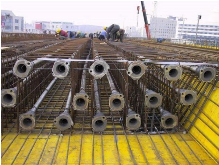
Figura 1.4: armatura di un ponte a cassone in C.A.P. con le guaine dei cavi da precompressione posizionate.
