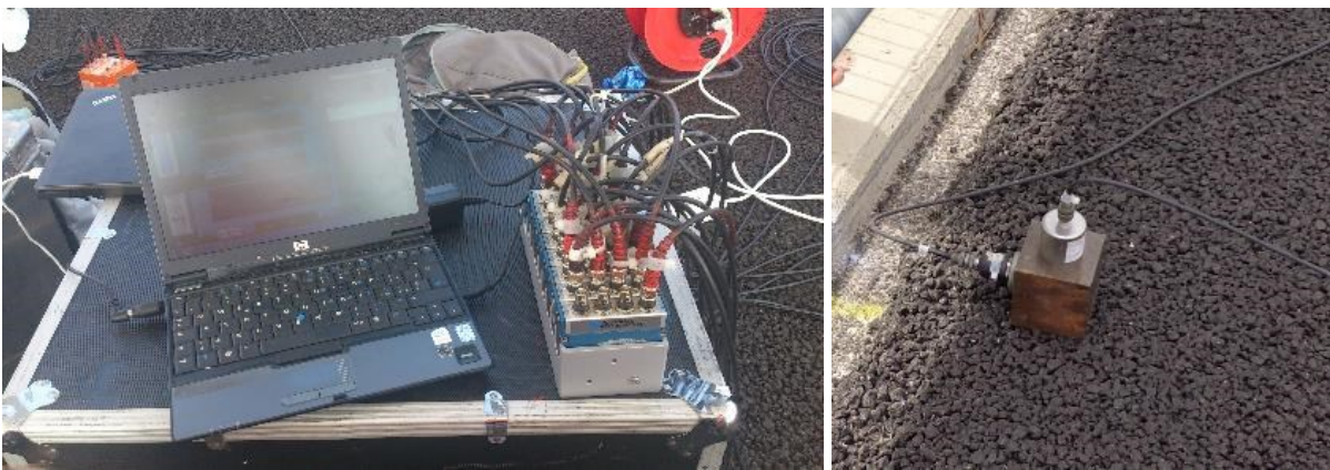
Figura 1.19: dettagli dell'apparecchiatura impiegata nelle prove con eccitazione ambientale sui viadotti BreBeMi. Il set-up è costituito solo da sensori di misura, cavi e un sistema di acquisizione.
