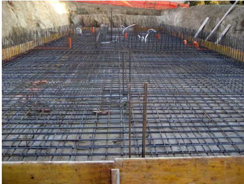
Figura 1.3: esempio di fondazioni in calcestruzzo armato.
