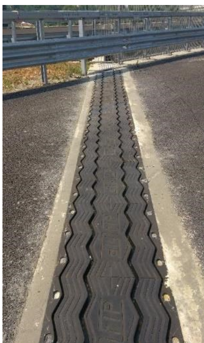
Figura 5.5: Giunto di dilatazione in gomma armata tipo FIP GPE200 [14].
