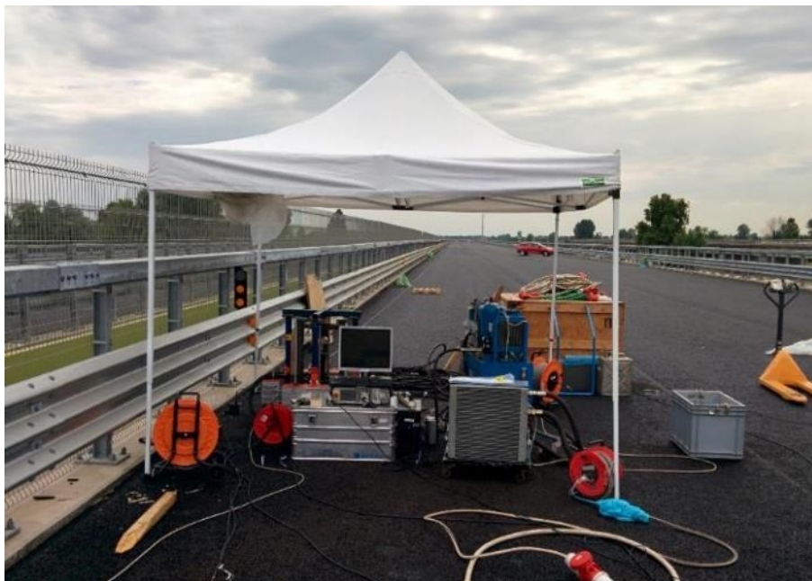
Figura 1.2: esempio di collaudo dinamico di un ponte autostradale.
