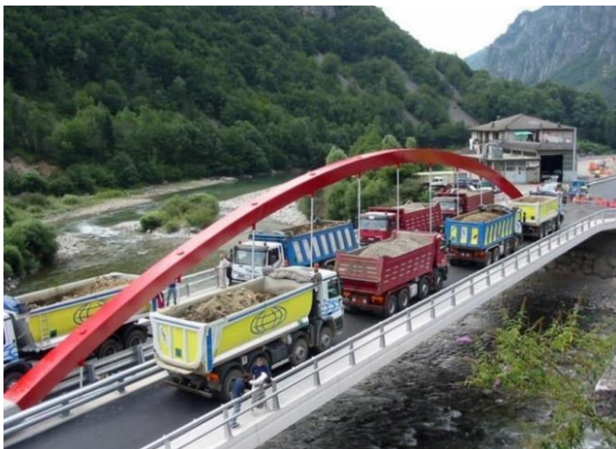
Figura 1.1: esempio di collaudo statico di un ponte stradale.
