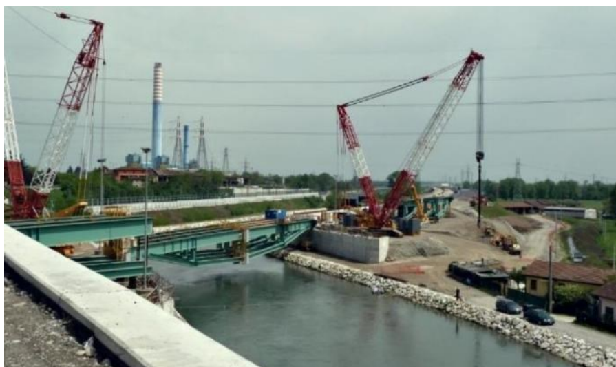
Figura 5.4: fase di varo delle strutture metalliche di supporto del ponte Muzza.
