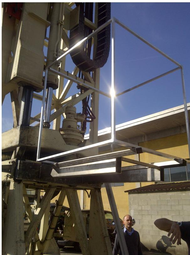
**Figura 5.7:** Struttura di sostegno del piano degli spot superiori, in fase di assemblaggio.
