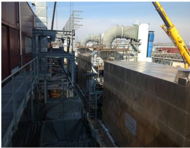
Figura 1.10 Installazione delle caldaie ausiliarie
