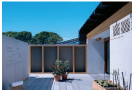
Fig.9.2.17-MED in Italy, vista del locale tecnico, raggiungibile dal patio interno
