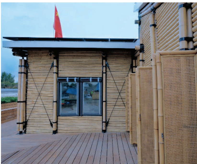
Fig.9.1.37 -Bamboo House, bamboo utilizzato come elemento strutturale, rivestimento esterno e pavimentazione interna
