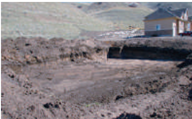
Fig.3.1.72 - Prima fase di cantiere dato dallo scavo
