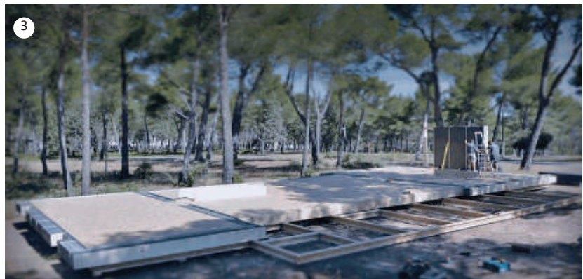
Fig.10.1.20 -Pop up house, Sequenza realizzativa della Pop-Up House - 4 giorni - 4 lavoratori, fase 3: realizzazione delle chiusure verticali opache
