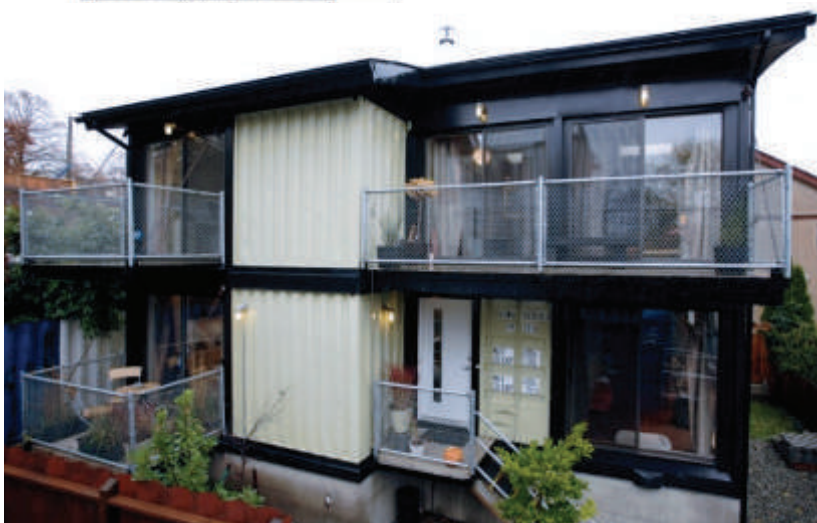
Fig.6.3.11 - Foto esterna della costruzione in cui emerge la struttura originale costituente di containers Zigloo domestique - Keith Dewey - Victoria - Canada - 2012
