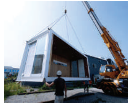
Fig.4.2.13 - Foto del trasporto della costruzione prefabbricata e finita
