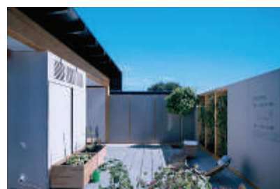
Fig.9.2.11-MED in Italy, viste sul patio interno
