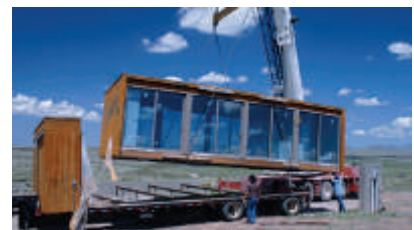
Fig.6.2.5 - Foto dello scaricamento della Wee House
