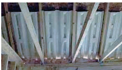
Fig.3.1.80 - "Roofing" Impermeabilizzazione del tetto mediante guaina in bitume
