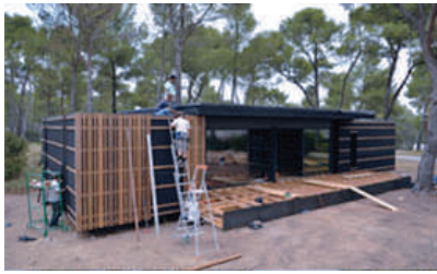
Fig.10.1.2 -Pop up house, realizzazione
