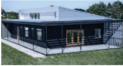
Fig.4.2.18 - Foto dell'esterno dell'abitazione completata Upcycle House - Lendager Arkitekter - Danimarca- 2013
