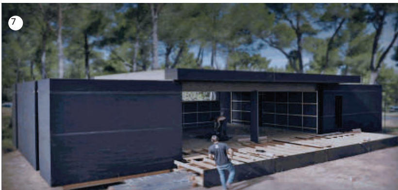
Fig.8.1.24 -Pop up house, Sequenza realizzativa della Pop-Up House - 4 giorni - 4 lavoratori, fase 7: conclusione chiusure opache e fissaggio serramenti
