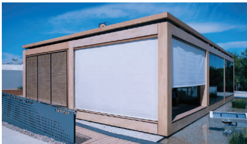
Fig.9.2.42- ECOLAR, vista delle schermature mobili
