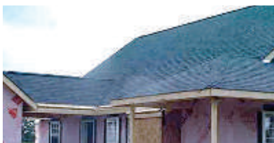
Fig.3.1.80 - "Roofing" Impermeabilizzazione del tetto mediante guaina in bitume
