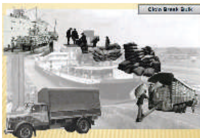
Fig.5.1.1 - Ciclo Break Bulk. Ciclo di scaricamento dalla nave delle merci in sacchi e trasporto in spalla fino ai rispettivi mezzi di trasporto
