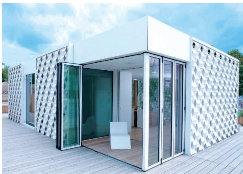
Fig.9.1.7-Ikaros House, viste degli esterni
