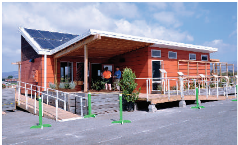
Fig.9.3.11 -Phoenix House, vista degli esterni
