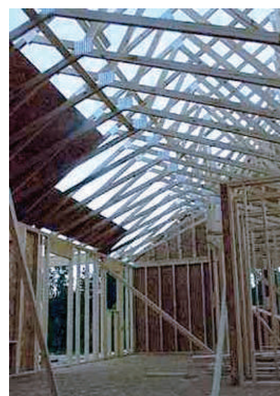
Fig.3.1.77 - “Framing” completo della struttura in legno delle case. Montaggio dei pannelli OSB di irrigidimento della copertura
