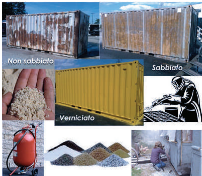
Fig.4.3.6 - Operazioni preliminari di trattamento superficiale del container
