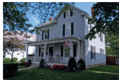
Fig.3.1.14 - Casa in stile coloniale di medio - basso reddito con portico antistante di ingresso
