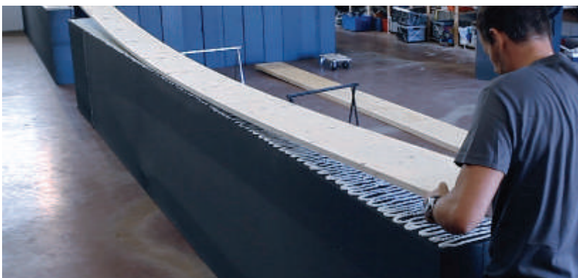
Fig.10.1.15 -Pop up house, Processo di posa delle strisce pretagliate di legno LVL,
