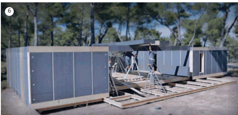
Fig.8.1.23 -Pop up house, Sequenza realizzativa della Pop-Up House - 4 giorni - 4 lavoratori, fase 6: realizzazione copertura con i medesimi moduli di solaio e pareti.
