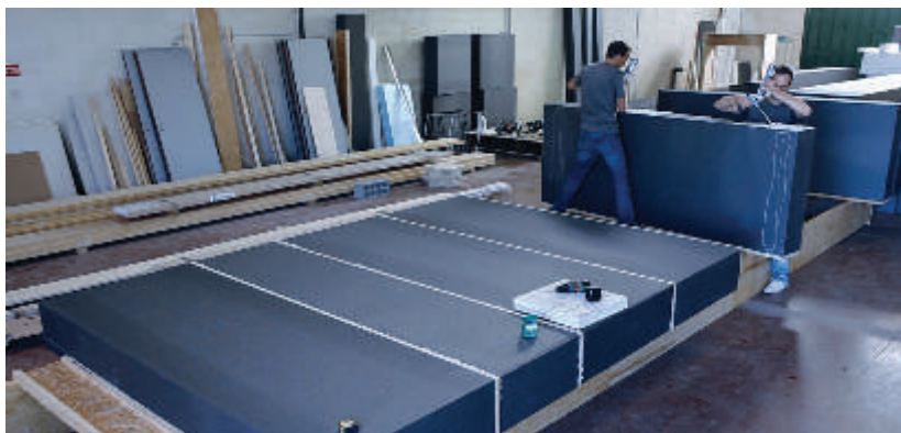
Fig.10.1.16 -Pop up house, Processo di posa delle strisce pretagliate di legno LVL,
