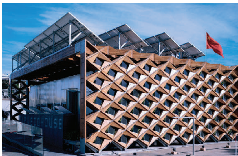
Fig.9.2.24 Para Eco-House-vista esterna del sistema di ombreggiamento
