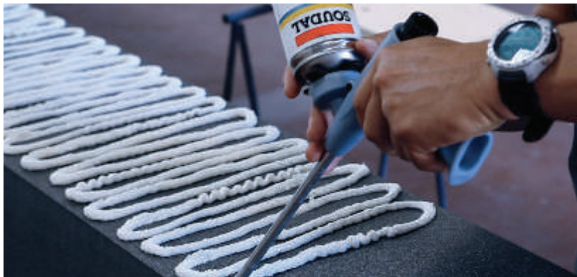
Fig.10.1.14 -Pop up house, Processo di produzione del modulo prefabbricato sandwich di parete composto da un blocco EPS 2.5 x 1 x 0.3 rivestito da strisce pretagliate di legno LVL,
