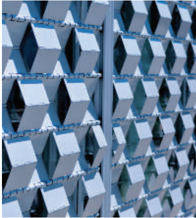
Fig.9.1.8- Ikaros House, rivestimento schermante metallico a fasce romboidali
