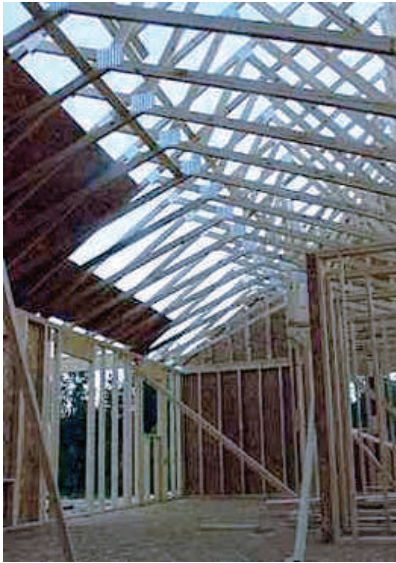
Fig.8.3.19 - Predisposizione delle capriate sulla palificata in legno e ricoprimento con pannelli OSB
