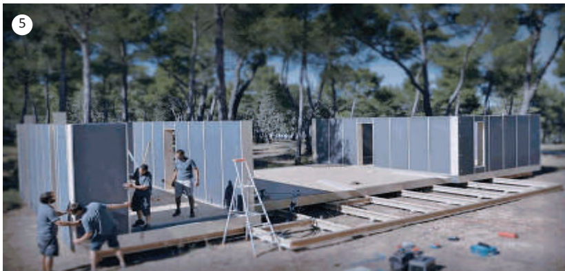
Fig.8.1.22 -Pop up house, Sequenza realizzativa della Pop-Up House - 4 giorni - 4 lavoratori, fase 5: fissaggio partizioni verticali
