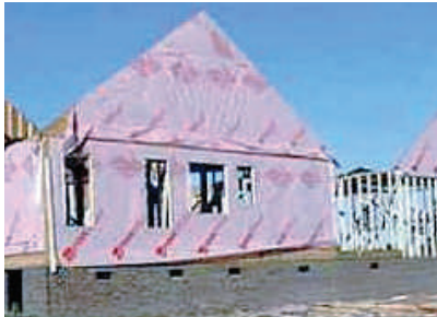
Fig.3.1.78 - Ricoprimento delle pareti esterne mediante membrana impermeabilizzante di colore rosa
