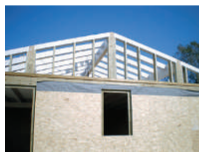
Fig.3.1.76 - Montaggio delle capriate prefabbricate in legno
