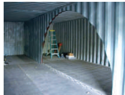
Fig.11.2.4 - Operazioni preliminari di taglio delle pareti per ricavare le aperture interne in accordo con il progetto dell'edificio
