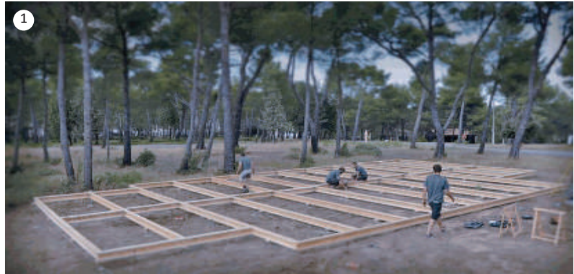
Fig.10.1.18 -Pop up house, Sequenza realizzativa della Pop-Up House - 4 giorni - 4 lavoratori, fase 1: preparazione delle fondazioni in legno
