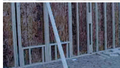
Fig.3.1.75 - “Framing” Montaggio della palificata di pareti costituite dai montanti in legno 2x 5 pollici ad interassi variabili ed uniti verso l'esterno da una lastra di osb di irrigidimento
