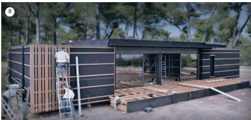
Fig.8.1.25 -Pop up house, Sequenza realizzativa della Pop-Up House - 4 giorni - 4 lavoratori, fase 8: realizzazione delle finiture costituite da montanti e traversi in legno.
