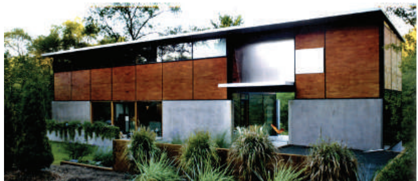
Fig.6.2.24 - Foto del fronte retrostante dell'abitazione
