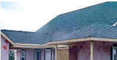
Fig.8.3.21 - "Roofing" Impermeabilizzazione del tetto mediante guaina in bitume
