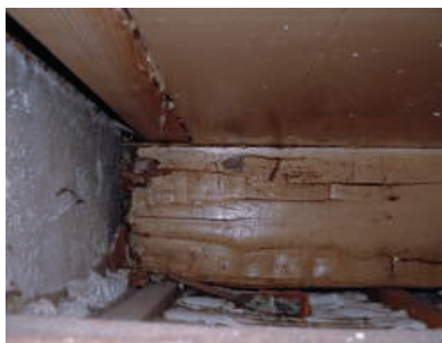
Fig.4.3.3 - Immagini di attacchi biologici delle termiti su strutture lignee
