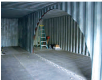
Fig.4.3.7 - Operazioni preliminari di taglio delle pareti per ricavare le aperture interne in accordo con il progetto dell'edificio
