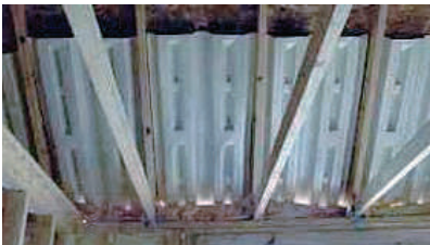
Fig.8.3.20 - Inserimento dell'isolamento tra la struttura del tetto
