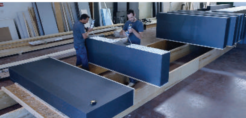
Fig.10.1.17 -Pop up house, Processo di posa delle strisce pretagliate di legno LVL,
