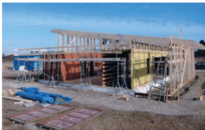
Fig.6.3.29 -Foto della cantierizzazione dell'edificio con i container a cuore strutturale
