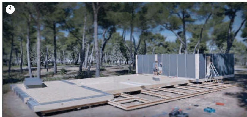
Fig.10.1.21 -Pop up house, Sequenza realizzativa della Pop-Up House - 4 giorni - 4 lavoratori, fase 4: realizzazione delle chiusure verticali opache
