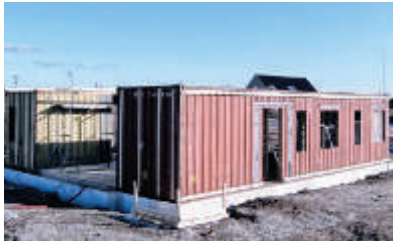
Fig.4.2.17 - Foto del posizionamento dei due containers da cui è generata la pianta dell'edificio
