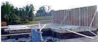
Fig.8.3.9 - Immagine della "Palificata" ossia della costruzione delle pareti verticali sulla base di cemento non isolata
