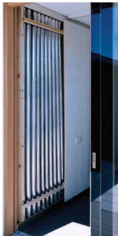
Fig.9.2.16-MED in Italy, sistema di tubazione in alluminio, riempito di sabbia umida
