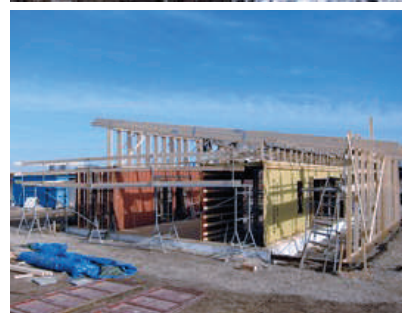
Fig.4.2.9 - Foto del processo realizzativo dell'edificio mediante moduli a containers
