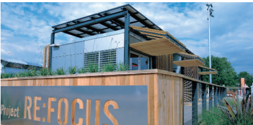
Fig.9.1.31 -RE:Focus, sistema di schermature mobili lignee
