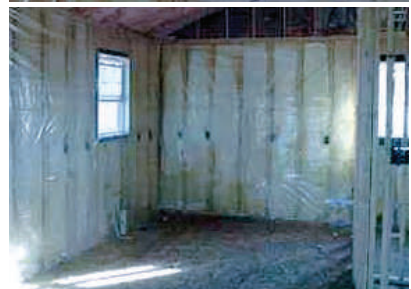
Fig.3.1.81 - Isolamento dato dall'inserimento di pannelli isolanti tra i montanti strutturali di copertura e di parete che determinano la creazione di una serie di ponti termici localizzati
