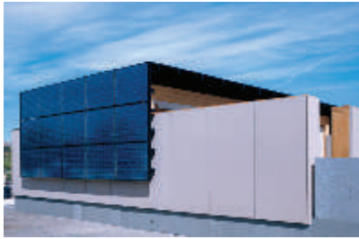
Fig.9.2.18-MED in Italy, vista esterna con moduli fotovoltaici
