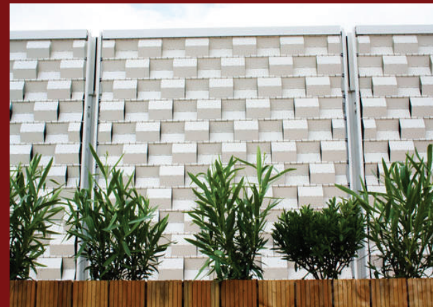
Fig. 2.1.30 _ Dettaglio del rivestimento
