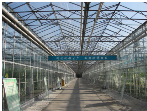
Serra di tipo VENLO, 30.000 mq a Shanghai Zhangjian Hitech Park, South area Shanghai Sunqiao modern development zone foto dell'autore
