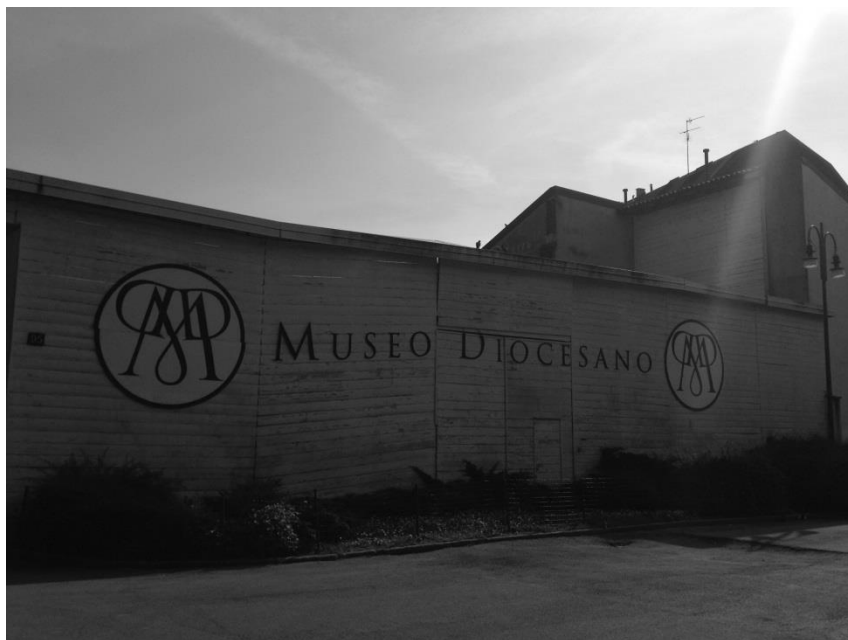
La chiusura provvisoria del braccio del chiostro mancante
