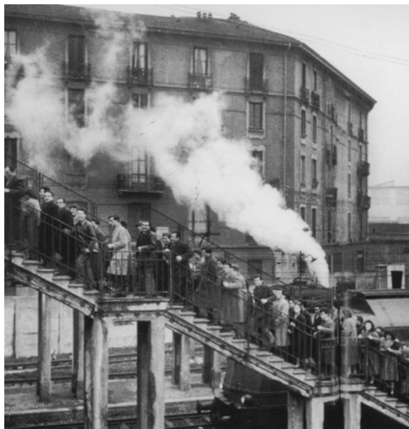
Rampa di accesso alla Stazione di S. Luigi Porta Romana, 1952
