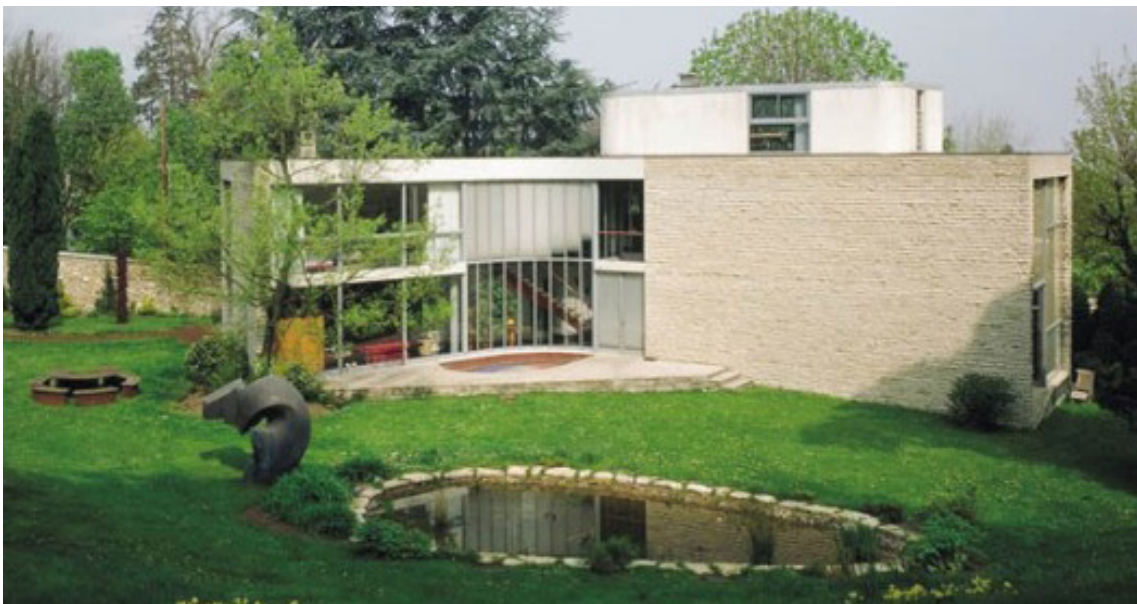
In basso vista della Casa Studio a Meuron
