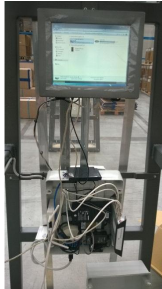
Figura 38. Portale RFID – Dispositivi di controllo
