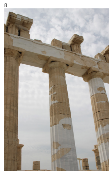
8 Anastilosi delle colonne del Partenone, Atene Anastylosis of Parthenon's columns, Athens
