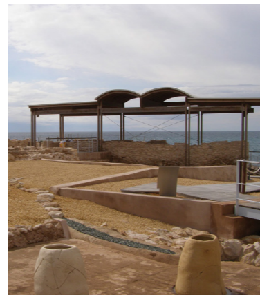
Copertura delle terme romane di Illeta dels Banyets ad Alicante, Spagna Progettata da Rafael Pérez Jiménez, 2004 The roofing of the Roman baths in the Illeta dels Banyets site in Alicante, Spain Design by Rafael Pérez Jiménez, 2004
