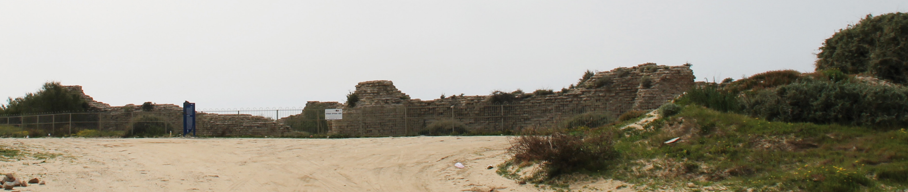
fronte est della fortezza East facade of the fortress 48
