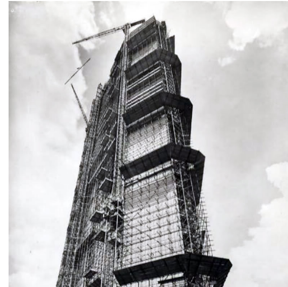
Figura 1.08: Grattacielo Pirelli in costruzione, Milano, 1958 circa
