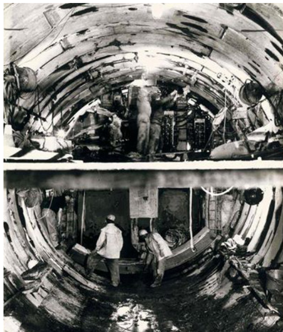
Figura 1.15: Costruzione della linea 1 della Metropolitana milanese (1960)
