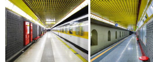
MATERIALI pavimento: piastrelle, pareti: calcestruzzo fessato
