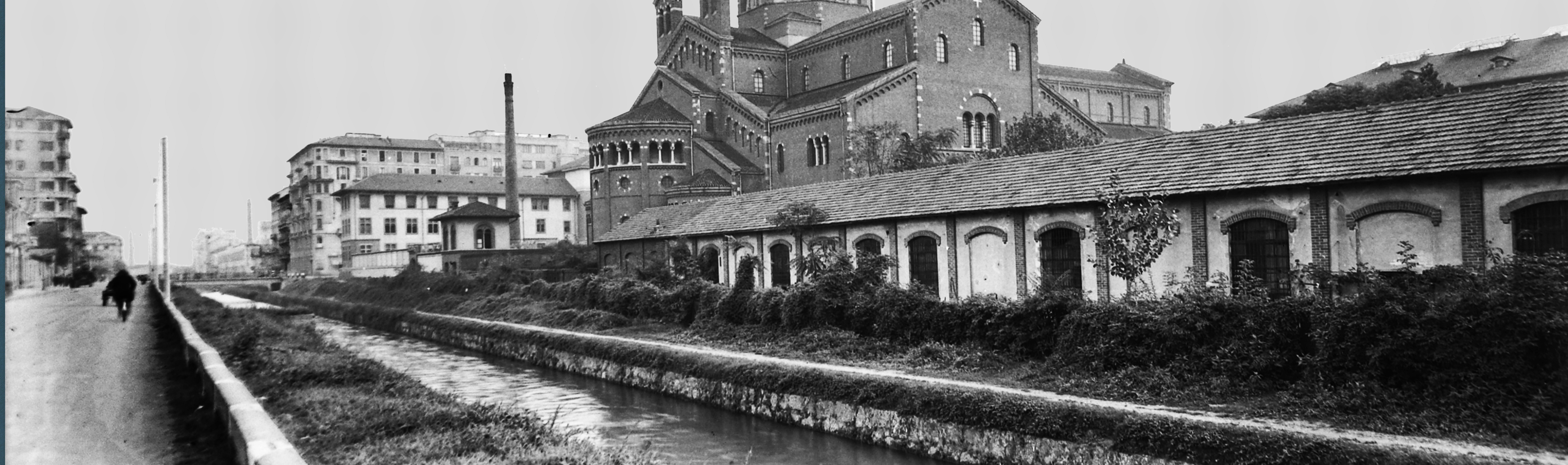
In ordine dall'alto verso il basso: - Prospetti del progetto originario - Ricostruzione per fasi storiche del complesso dei Salesiani - Foto storica dei laboratori affacciati sul Naviglio della Martesana
