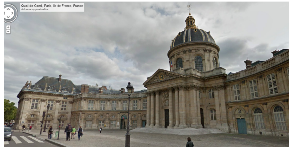
6 - Facciata neoclassica del Institut de France
