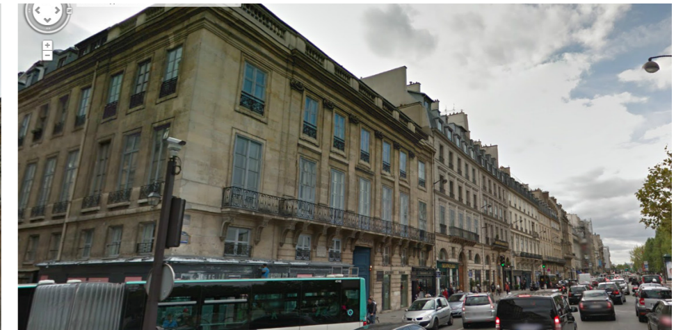
7 - Facciate di tipo Haussmann del Quai Voltaire
