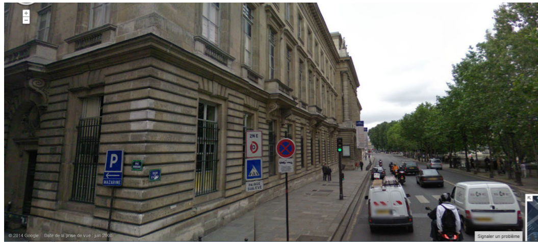
5 - Facciata neoclassica del Hotel de la Monnaie
