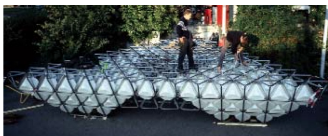
Fig. 19 Principio di galleggiamento D - Sistema N55: la struttura reticolare è basata su moduli triangolari che creano spazi in cui sono inseriti blocchi ottaedrici di polietilene a bassa densità. La concentrazione di elementi galleggianti è rinforzata agli angoli della piattaforma.
