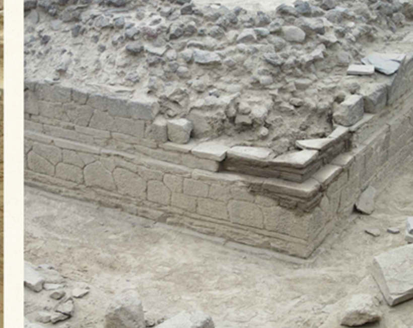
Fissaggio degli scisti con malta di argilla
