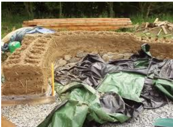
15.3.3b Muro con la tecnica del Bauge/Cob
