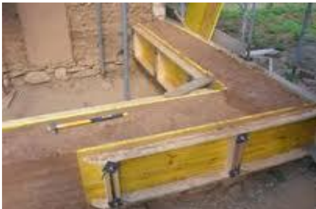
15.3.2a Preparazione dei casseri
