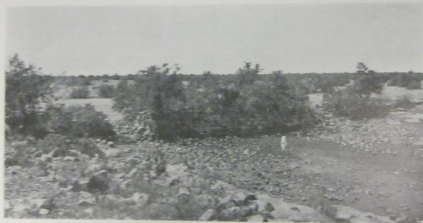
Abb. 308. Das große Staubecken mit Staumauer in Kohaito, von Nordosten gesehen.
