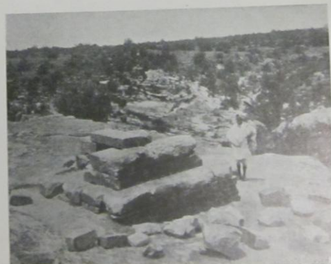
Abb. 312. Kohaito. Der Erhaltungszustand des Oberbaues eines alt-christlichen Felsengrabes.
