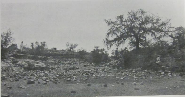
Abb. 309. Östlicher Teil der großen Staumauer in Kohaito mit rechtwinklig anschließender Flügelmauer.
