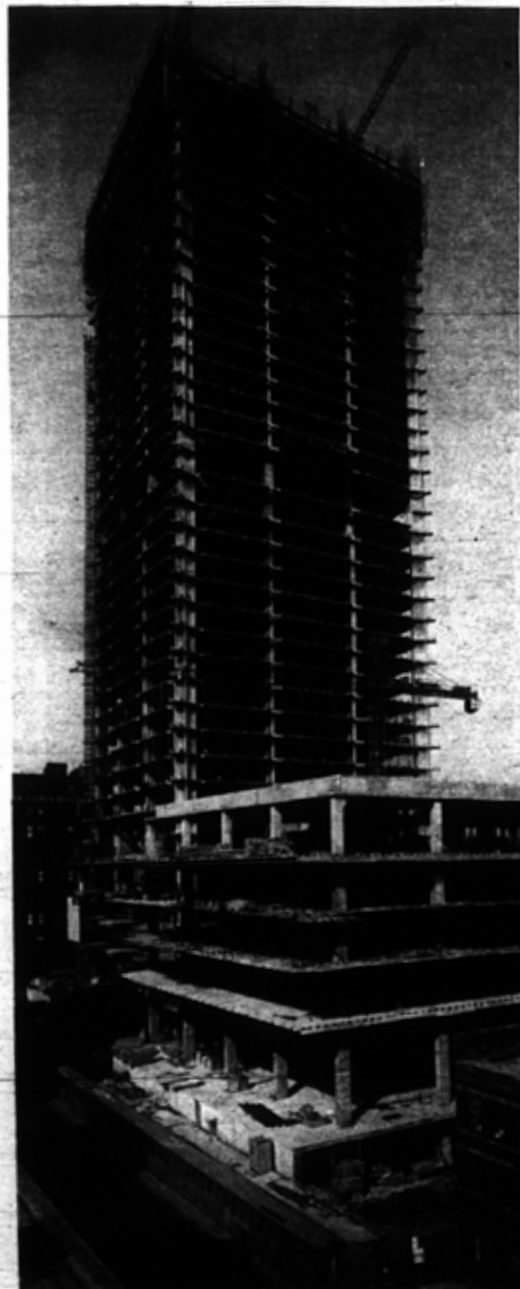
VUE DE L'ÉDIFICE INTERMÉDIAIRE, où sera logée la Bourse en 1965. En arrière la tour s'est élevée avec rapidité. Pendant le mois de juin, un record a été établi en construisant le 43ième étage en 53 heures et 15 minutes.
