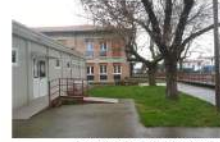
Ingresso mensa, edificio temporaneo.
