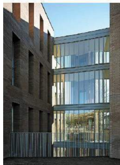
77. Ballatoi vetrati del Complesso.
