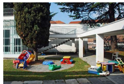
302. Cortile interno, foto attuale.
