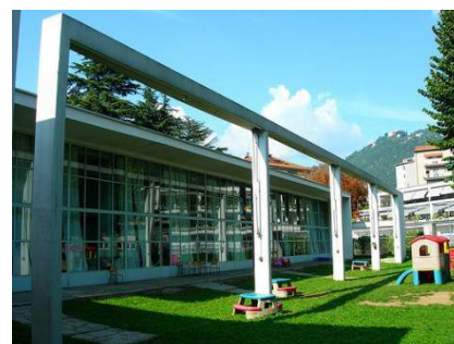
308. Vetrata che si affaccia sul giardino interno.
