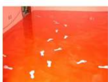
Pavimentazione in resina con percorsi.
