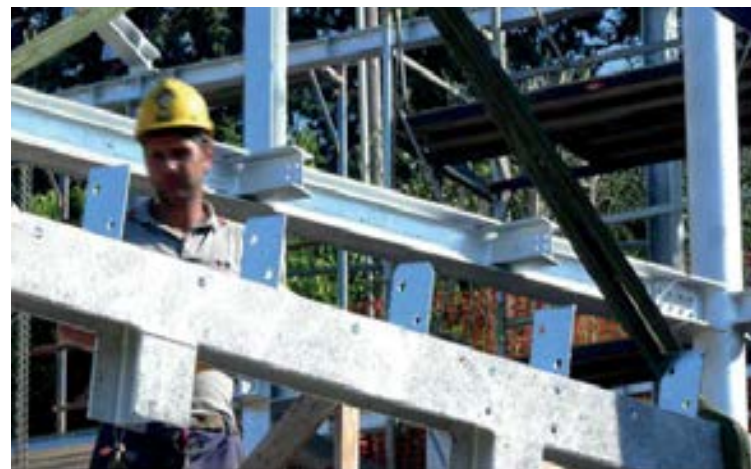
Fig.006 Esempio di assemblaggio della struttura metallica in cantiere
