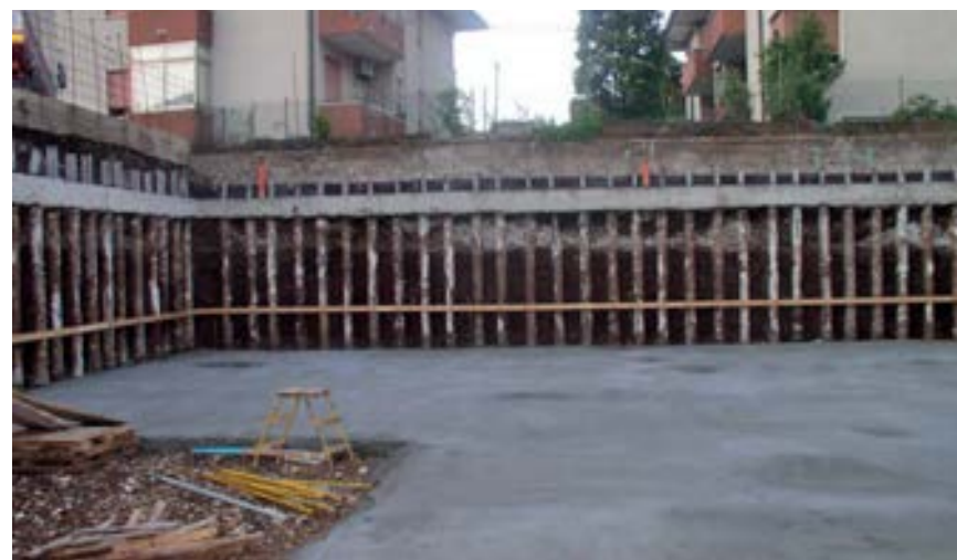
Fig.003 Esempio in cantiere di applicazione di micropali di sostegno
