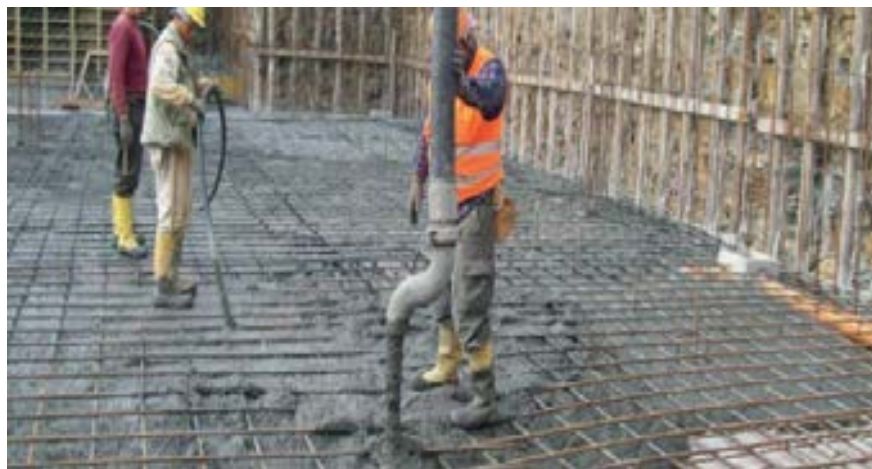
Fig.005 Esempio di getto delle fondazioni in cantiere
