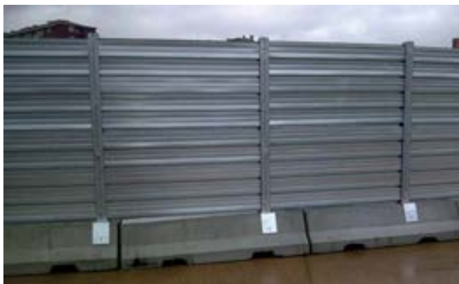
Fig.007 Esempio di recinzione in pannelli metallici
