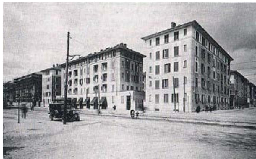
Fig.049 quartiere Solari, visto dalla via Giambellino (foto archivio lacpm)
