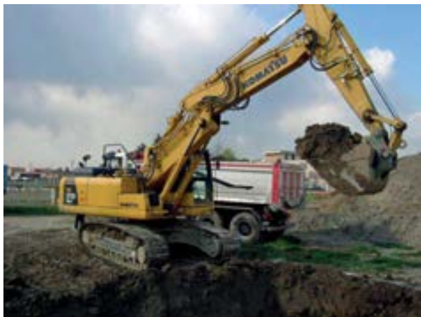
Fig.004 Esempio dei mezzi edili previsti per la fase di scavo
