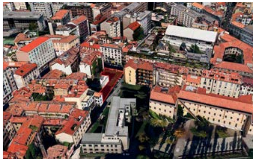
Fig.001 Localizzazione del cantiere in via Palermo
